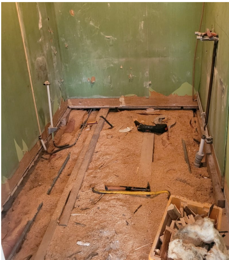
KUVA 9. Yläkerran välipohjaa, lattia avattu kylpyhuoneremontin yhteydessä
