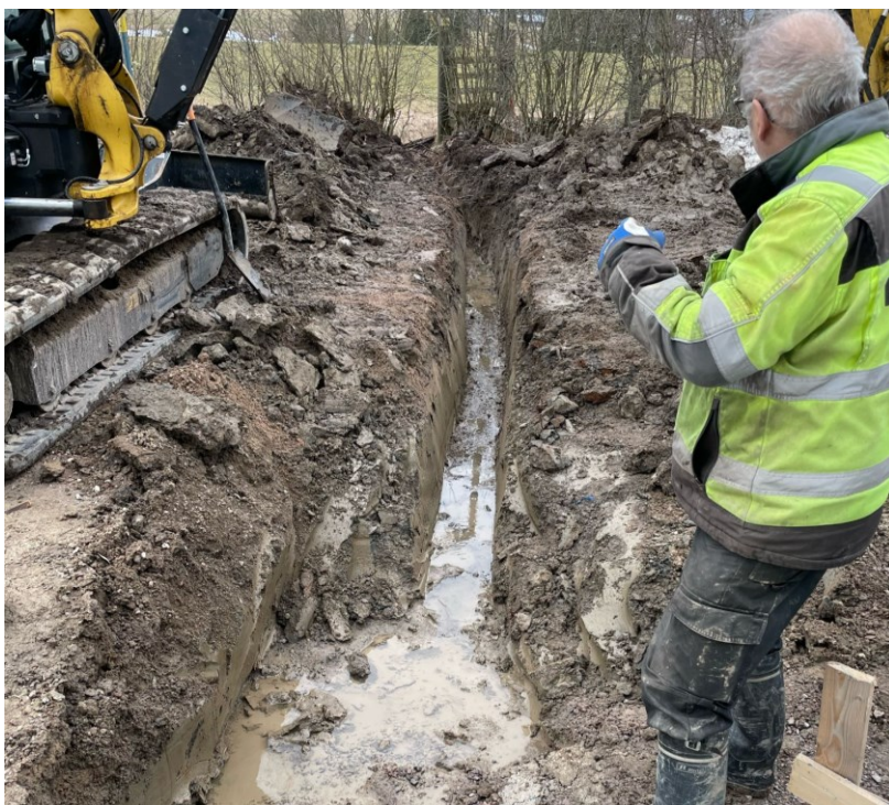
KUVA 13. Sadeveden- ja salaojienpurkuputken kaivantoa.
