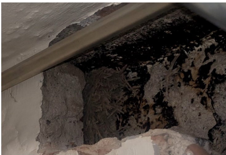
KUVA 35. Tojalevy ja verhomuuraus väliseinässä.
