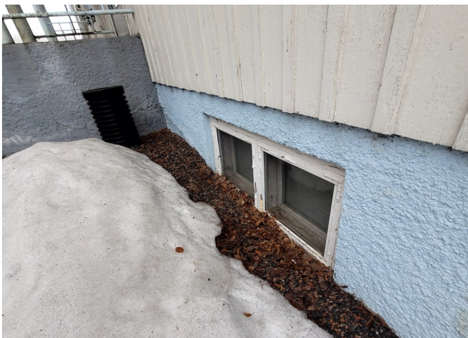
KUVA 15. Kellarin ikkuna maanpinnan alapuolella.
