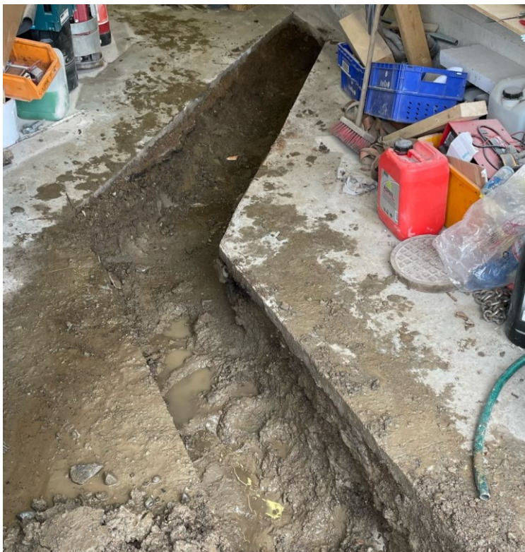
KUVA 34. Autotallin lattia avattiin lattiakaivon uusimisen yhteydessä.
