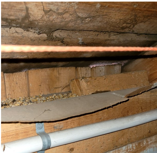
KUVA 43. Kylmä sivukas, räystäällä on pieniä ilmarakoja.
