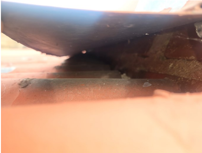
KUVA 33. Viistosade pääsee piipun juuresta kattorakenteisiin, aluskatteen nosto puuttuu ja pellitys on epätiivis.
