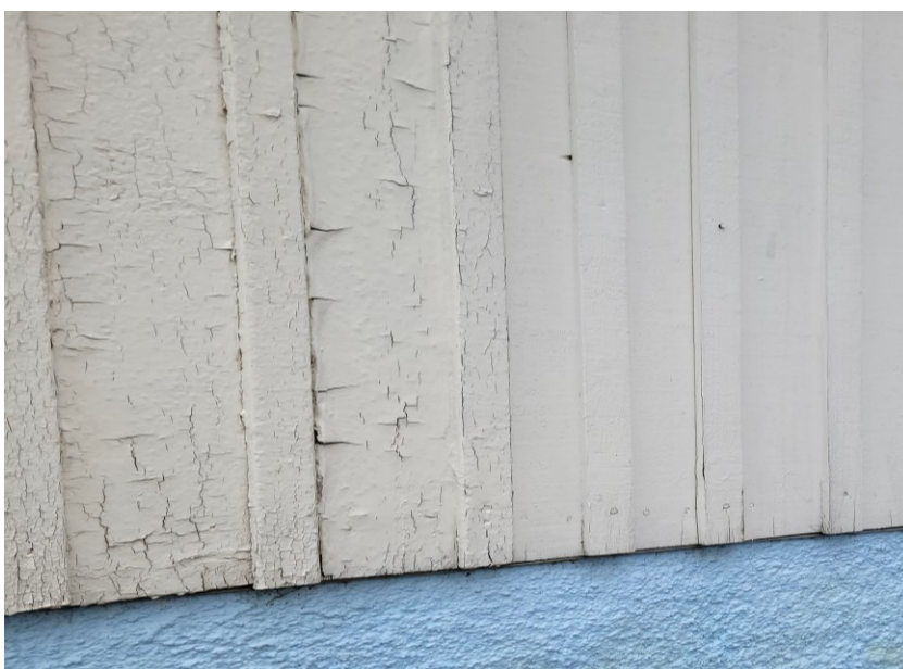
Kuva 17. Vanhaa ja uusittua laudoitusta.
