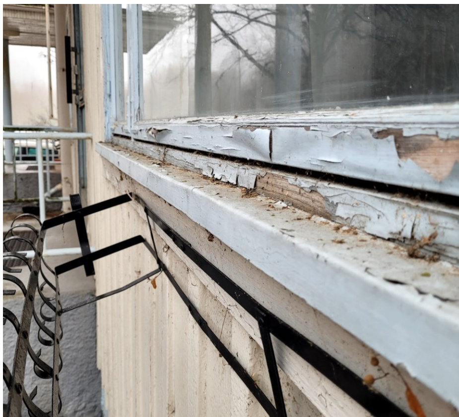
KUVA 20. Ikkunan vesipelti ohjaa veden ikkunaan kohti.
