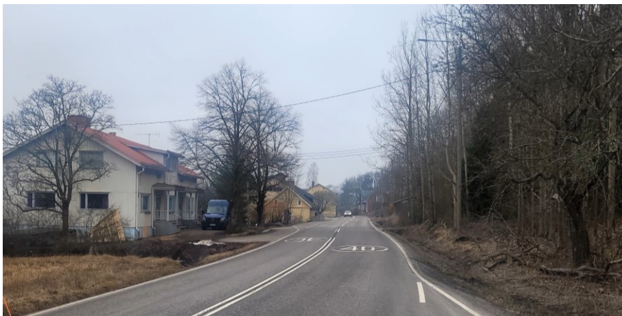
KUVA 10. Kiinteistö sijaitsee rinteessä maantien vieressä.
