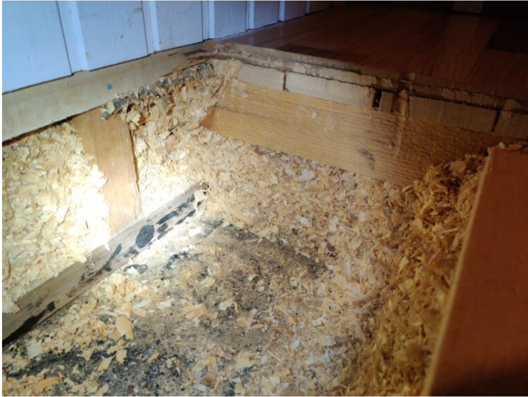
KUVA 5. Riskirakenne kellarin katon betonilaatan päälle rakennettu puukoolattu lattia (Käyhkö 2023).
