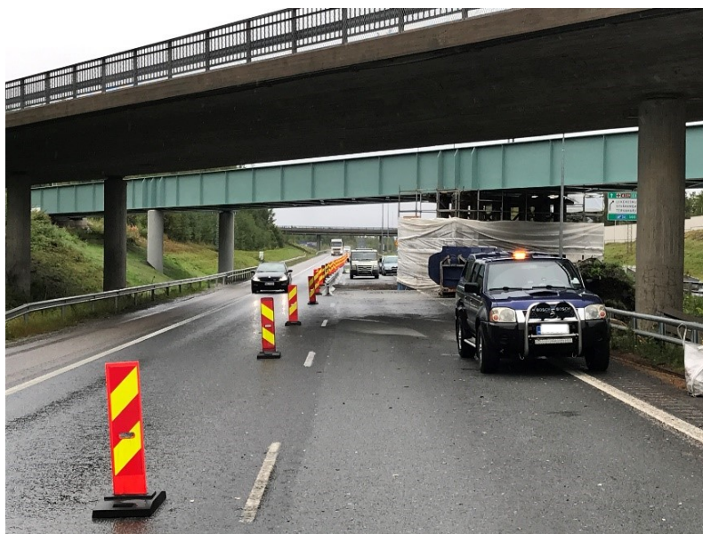
KUVA 20. Keskimmäisen välitukipilarin korjaustyö Jarkon alikulkusillalla Kemien moottoritieellä. Kuva Kai Kilpi 2023.
