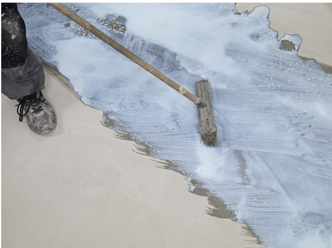
Kuva 18. ARDEX P 51 kaadetaan laimennettuna vedellä alustalle ja harjataan pintaan kauttaaltaan. Tuotetta ei saa jättää lammikoiksi levityksen jälkeen. (Ardex Oy:n kuvapankki-kuva.)
