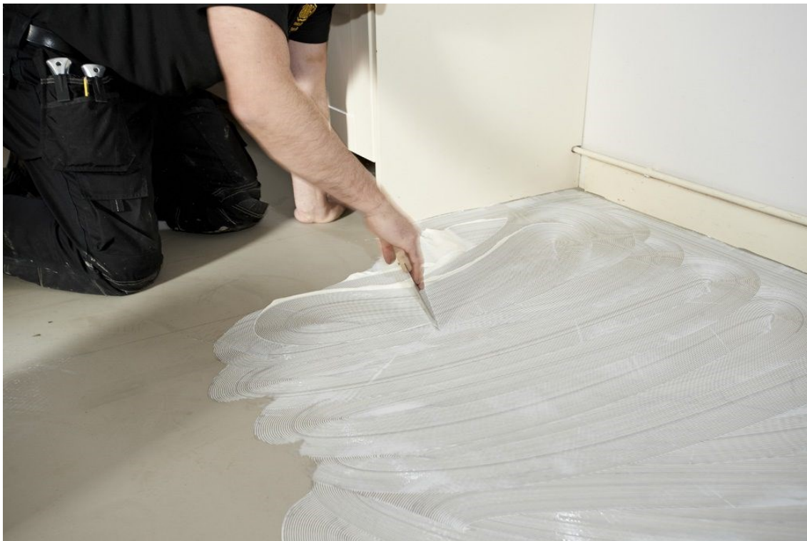
Kuva 20. ARDEX AF 145 levitetynä tasoitteen päälle (Ardex Oy:n kuvapankkikuva).
