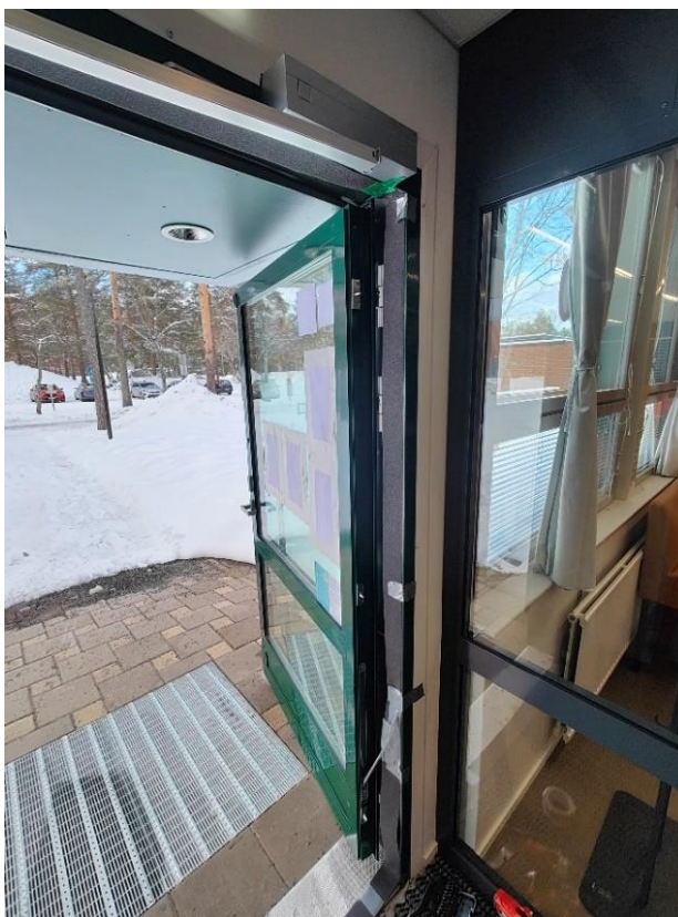
Kuva 21. Aukon tiivistämistä talotiivisteellä.
