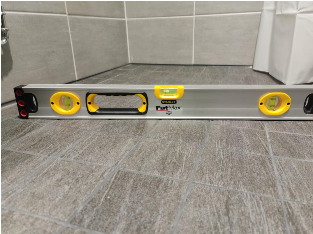
Kuva 41. Henkilökunnan suihkun lattian kaadon tarkistus.
