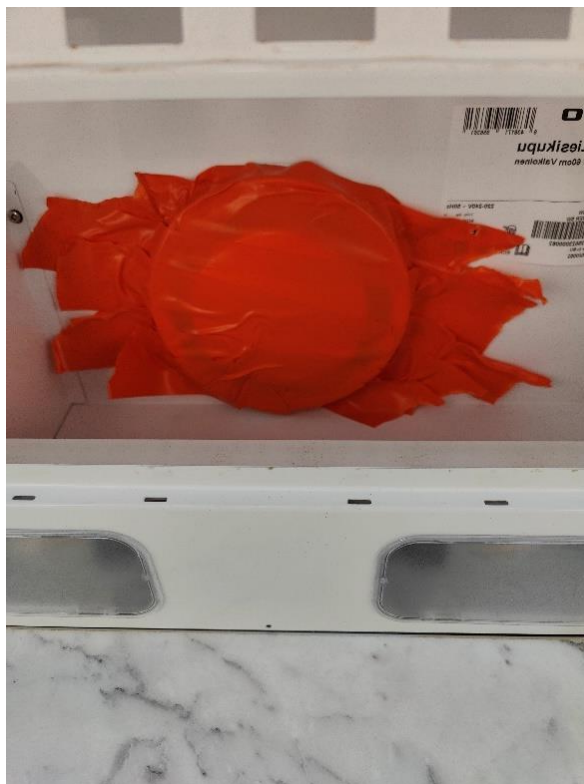
Kuva 16. Liesituulettimen poistoilmakanavan tukkiminen.
