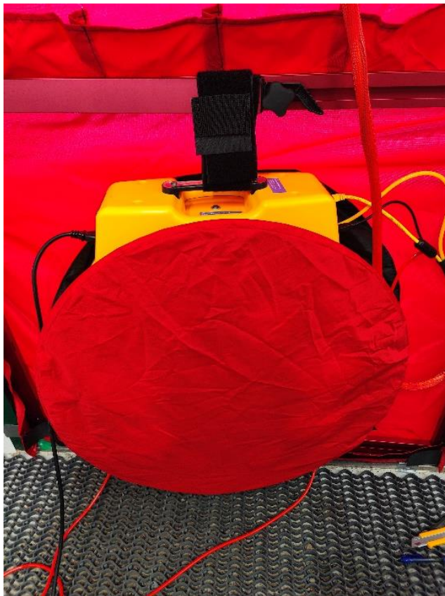
Kuva 22. Puhallin asennettuna paikalleen.
