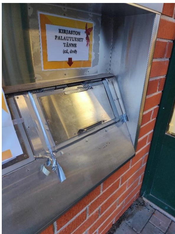
Kuva 15. Kirjaston palautusluukun tiivistäminen.
