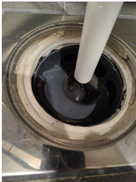
Kuva 18. Viemärikaivon vesilukon täyttäminen.
