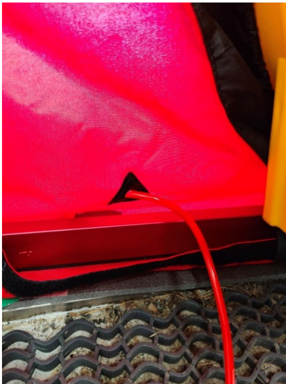
Kuva 25. Ulkoilman painetta mittaava putki läpäisee tiiviyspeiton.
