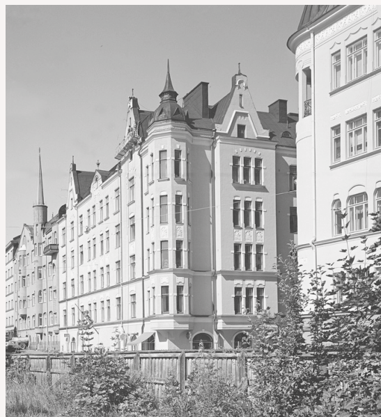
Kuva 23 Korostettuja kattolyhtyjä, poikkipäättyjä ja torniaiheita Pietarinkadulla (Hakli 1969)
