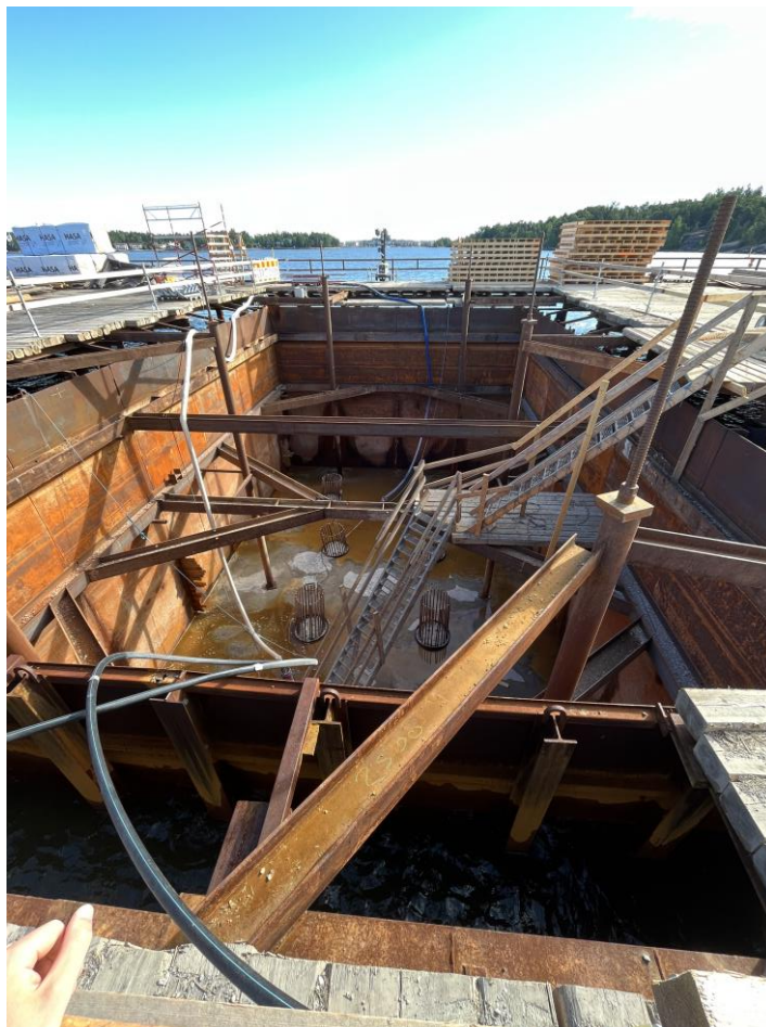
Kuva 5. Teräseinäinen kasuuni, Kruunuvuorensilta
