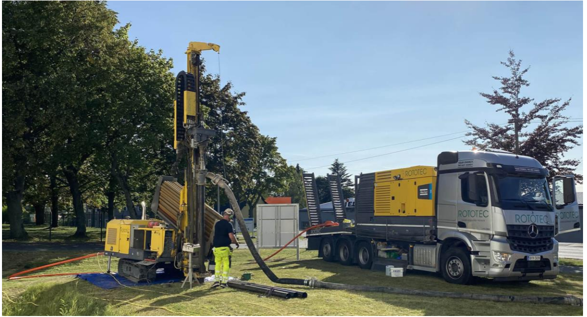
Kuva 7: Lämpökaivopora sekä sen kuljetukseen ja operointiin käytettävä ajoneuvo (30)
