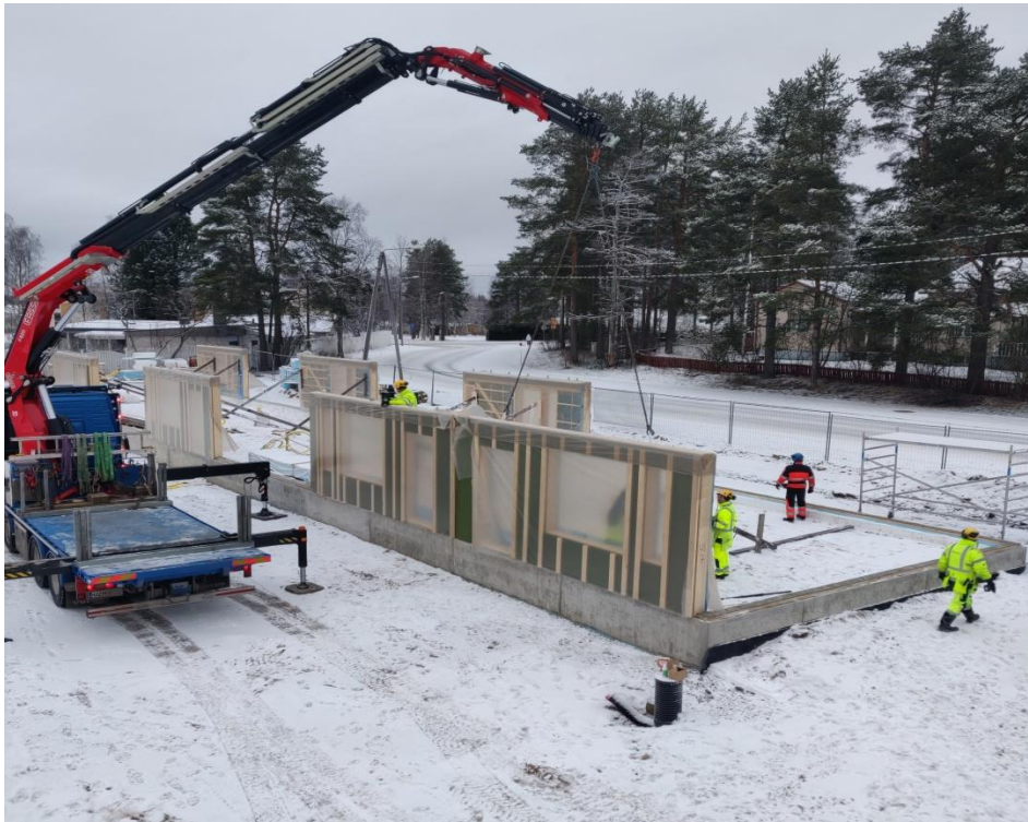
Kuvio 3. Ulkoseinäelementtien asennus
