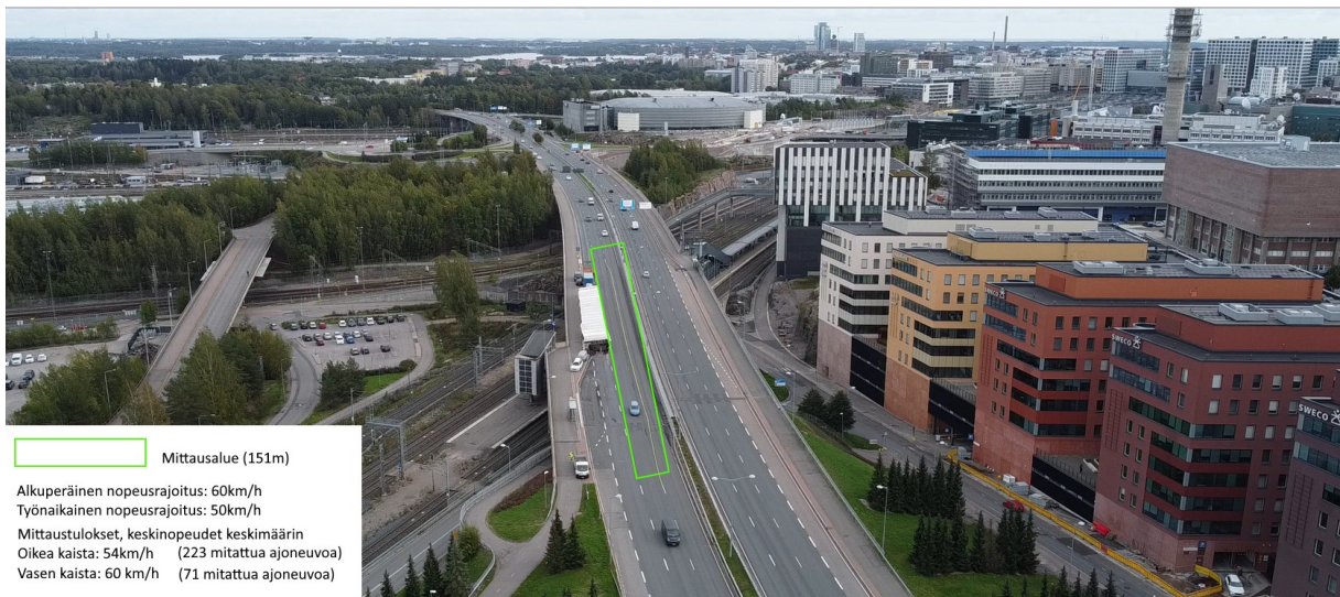
Kuva 22. Ilmakuva Metsämäentien sillasta (Kaasinen, 2023).
