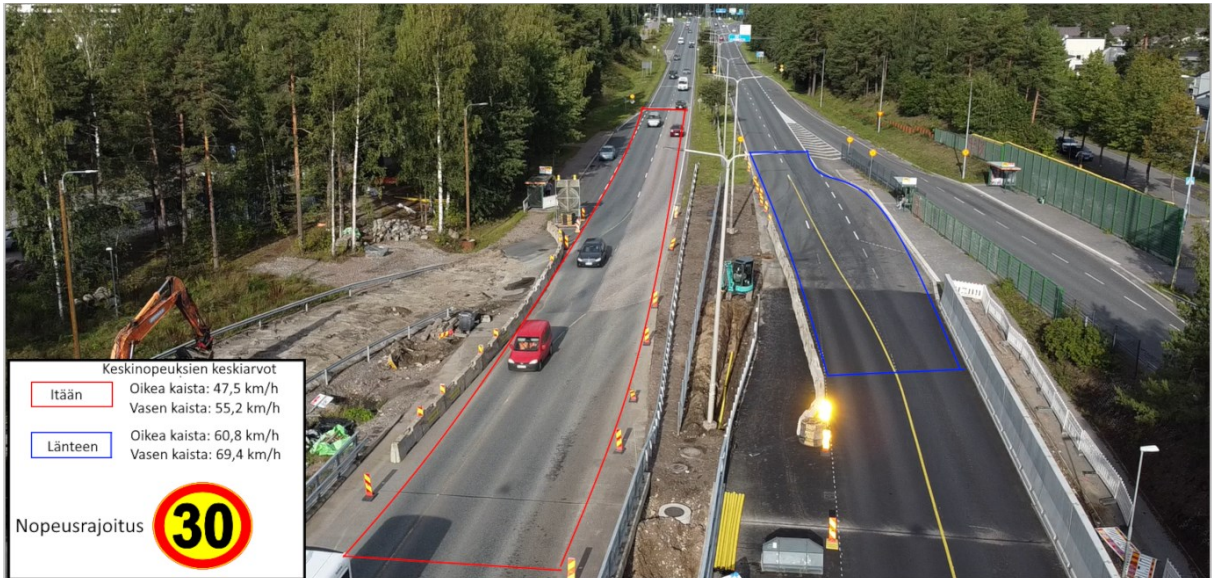
Kuva 20. Ilmakuva Kurkimäen alikulun työmaasta (Kaasinen, 2023).
