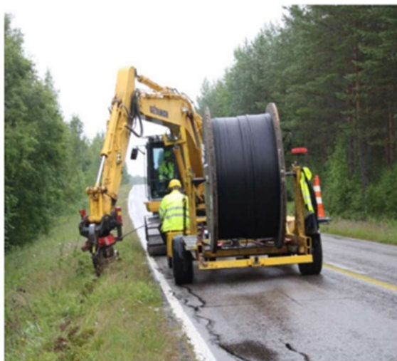
Kuva 7. Urakoitsijat auraamassa kaapelia maahan [4, s. 146].
