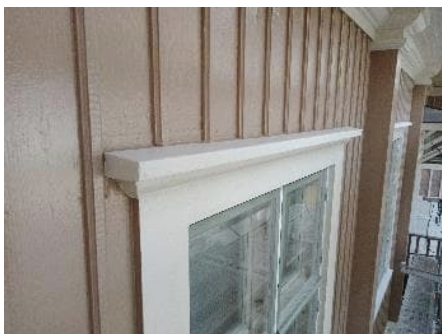
Kuva 73. Julkisivun epäjatkuvuuskohdat tiivistettiin.
