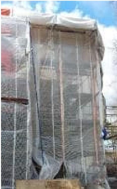
Kuva 59. Rakentaminen tapahtuu tarkastetun täyssääsuojauksen alla (kuvaaja: Wafa Ameli).
