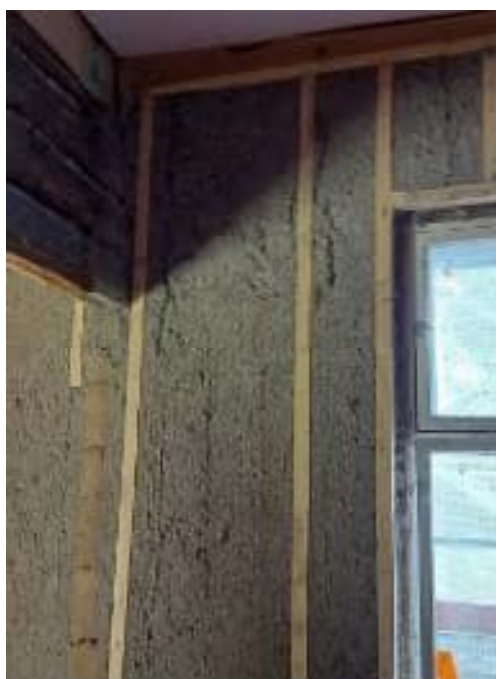
Kuva 56. Puhallusvillaeristeen asennukset seinään (kuvaaja: Wafa Ameli).
