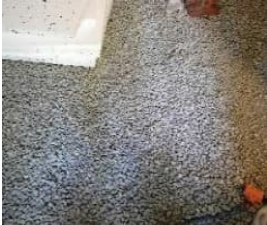
Kuva 61. Kapillaarikatkon asennus on ollut asiallinen ja siisti [18].
