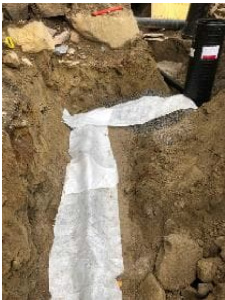
Kuva 66. Salaojalinjan asennus on dokumentoitu tarkasti.
