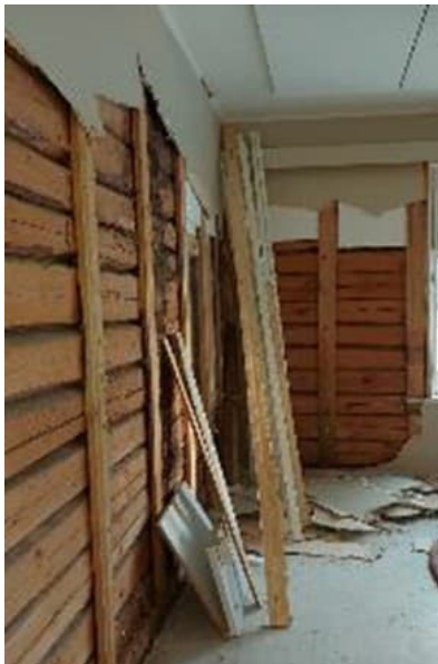
Kuva 35. Ulkoseinärakenteiden purkutyöt yleisesti kuvattuna (kuvaaja: Wafa Ameli).
