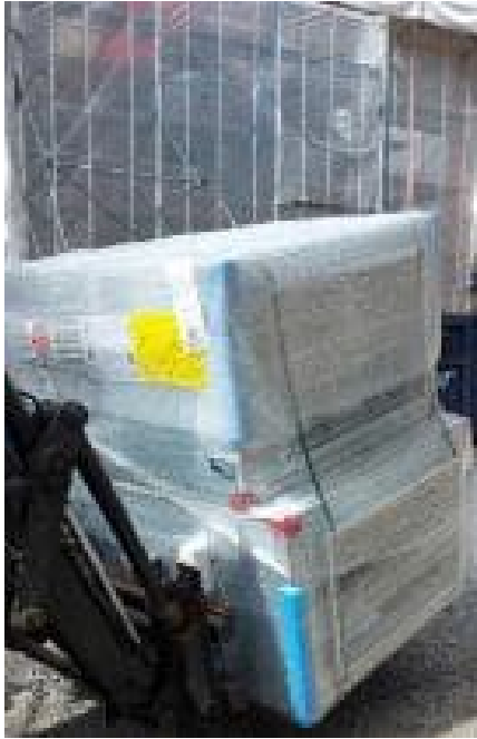
Kuva 60. Rakennusmateriaalit tuodaan työmaalla suojattuna (kuvaaja: Wafa Ameli).
