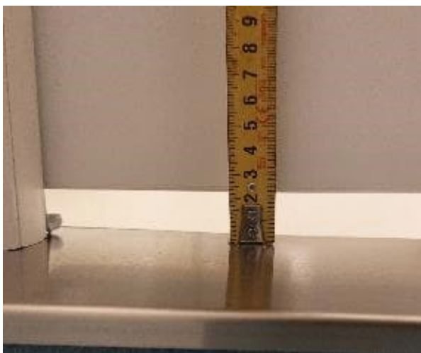
Kuva 80. Suihkutilan ovirako toimitettujen ohjeiden mukaisesti.
