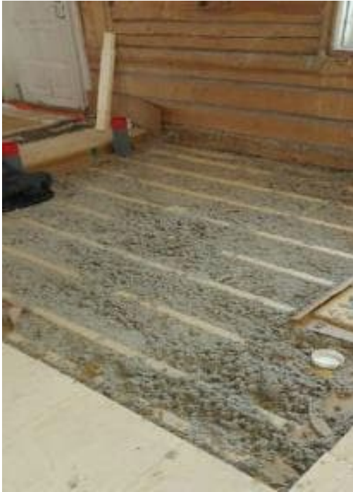
Kuva 49. Alapohjarakenteiden uusi lämmön eriste asennettiin materiaalivalmistajan ohjeita noudattaen (kuvaaja: Wafa Ameli).
