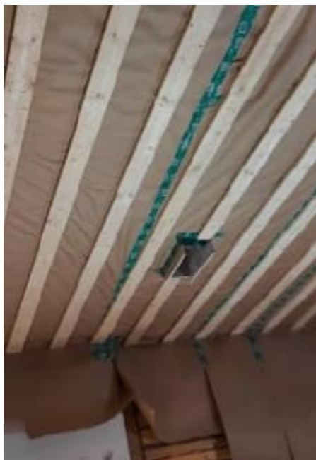
Kuva 55. Höyrinsulun asennus kattorakenteisiin valvottiin tehostetusti. Tarkastus luukkujen liittyminen höyrinsulkuun tiivistettiin käyttämällä tiivistysnauhaa (kuvaaja: Wafa Ameli).
