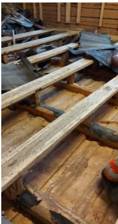
Kuva 43. Vanhat kermirakenteet ja vedeneristeet poistetaan (kuvaaja: Wafa Ameli).
