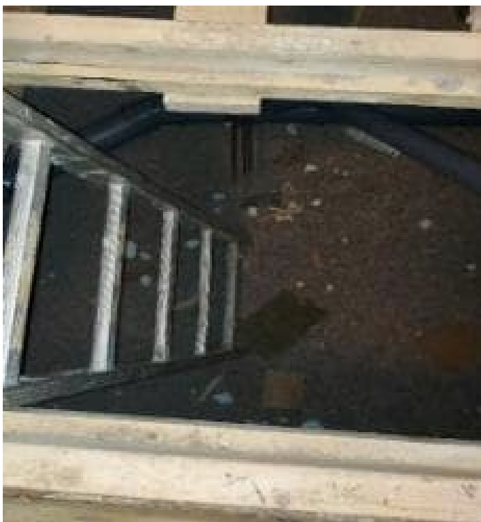
Kuva 46. Alapohjan kivimassat korjataan vastaman tehtyjä nykyvaatimuksia (kuvaaja: Wafa Ameli).
