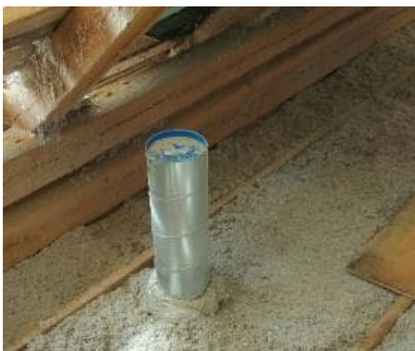
Kuva 58. Kaikki yläpohjarakennetta lävistäviä läpivientejä tiivistetään (kuvaaja: Wafa Ameli).
