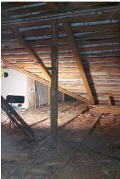
Kuva 36. Kattorakenteiden purkutyöt (kuvaaja: Wafa Ameli).
