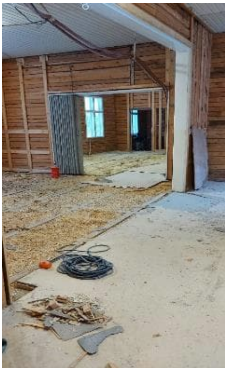
Kuva 38. Lattiarakenteiden purkutyöt, vanha eristemateriaali imuroidaan pois (kuvaaja: Wafa Ameli).
