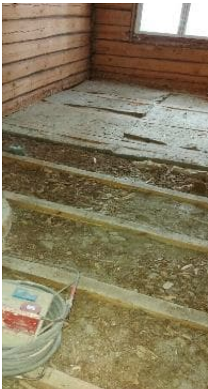
Kuva 44. Lattiarakenteista on havaittavissa monia erilaisia eristemateriaalia (kuvaaja: Wafa Ameli).
