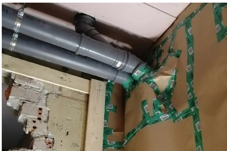
Kuva 77. Läpivientien tiivistykset on tehty suunnitelman mukaisesti.
