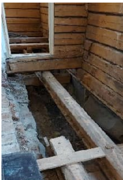
Kuva 45. Alapohjarakenteita puretaan kantavia rakenteita lukuun ottamatta. Vanhoja eristerakenteita poistetaan kauttaaltaan (kuvaaja: Wafa Ameli).
