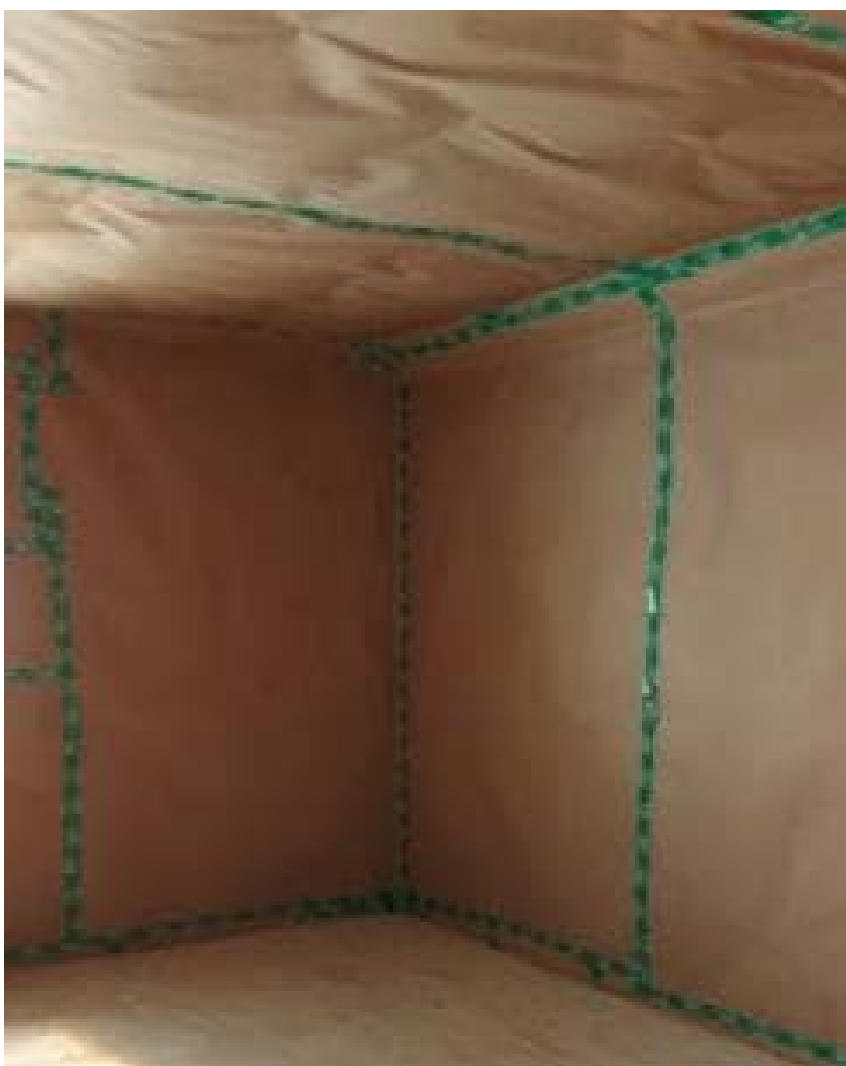
Kuva 54. Höyrynsulun asennus työmaalla valvotaan tehostetusti (kuvaaja: Wafa Ameli).
