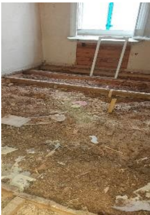
Kuva 37. Lattiarakenteiden purkutyöt, vanha eristemateriaali imuroidaan pois (kuvaaja: Wafa Ameli).
