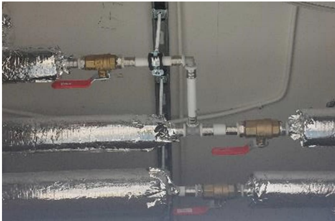
Kuva 84. Kannakointi vastaa työmaalle toimitettuja suunnitelmia.
