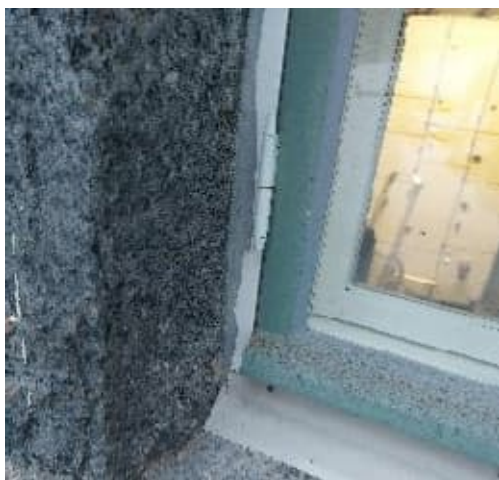
Kuva 70. Ikkunarakenteiden liittymäkohdat on tiivistetty ympäröiviin rakenteisiin.
