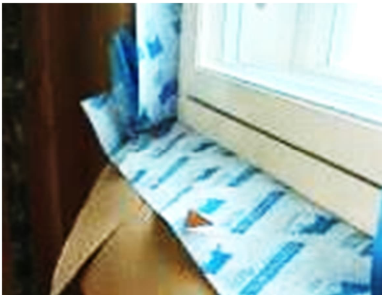
Kuva 50. Tiivistysnauhan asennustyömaalla valvotaan tehostetusti (kuvaaja: Wafa Ameli).
