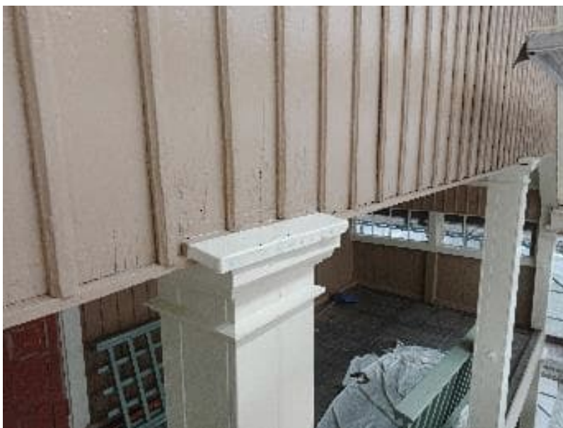
Kuva 72. Pellitysten, saumausten ja tiivistysten suorittaminen työmaalla dokumentoitiin tarkasti.
