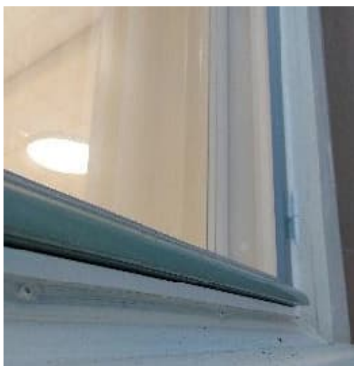
Kuva 71. Ikkunarakenteiden liittymäkohdat on tiivistetty ympäröiviin rakenteisiin.
