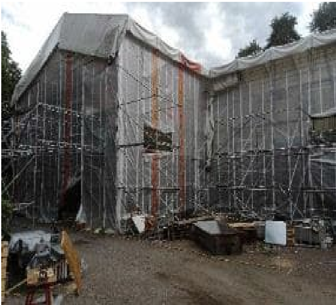
Kuva 95. Rakentaminen täyssuojauksen alla (huputus) [19.].
