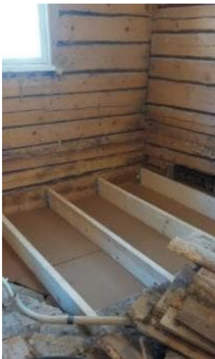
Kuva 48. Osa huonossa kunnossa olevista kantavista puuparruista purettiin ja uusittiin (kuvaaja: Wafa Ameli).
