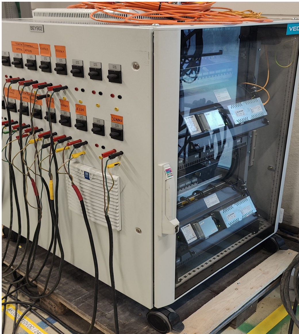
Kuva 10. 110 VDC /24 VDC akusto.
