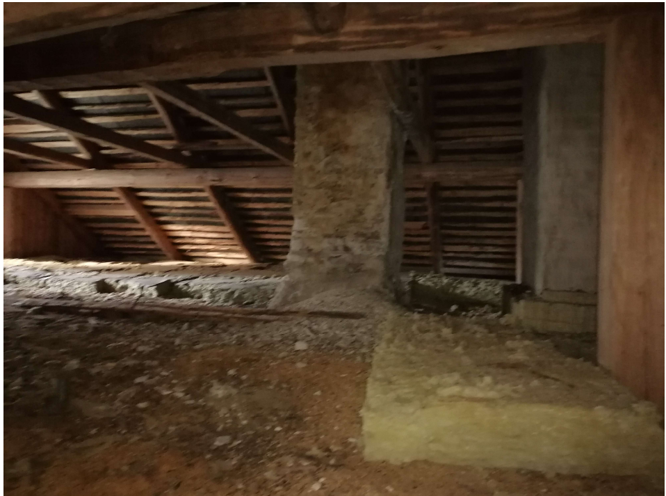
Kuva 1. Esittää tutkittavia yläpohjan rakenteita tarkastellaan huolellisesti tutkimuksen aikana.
