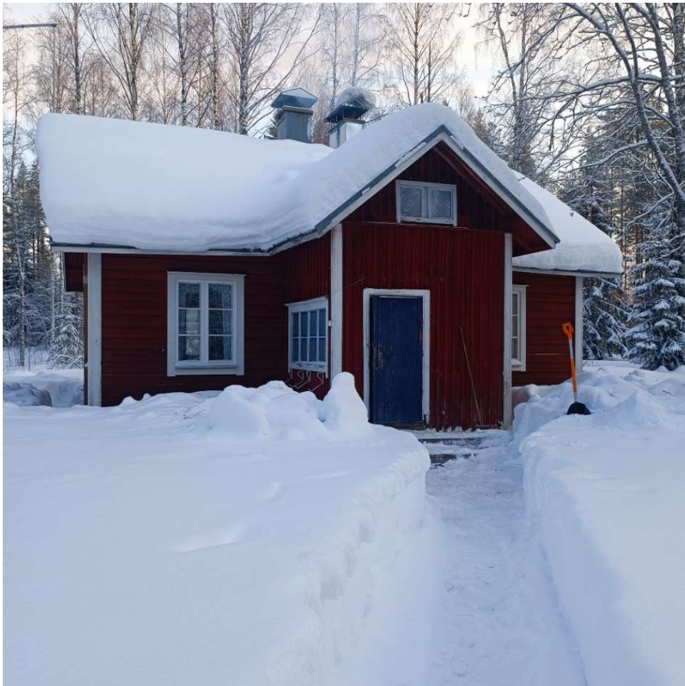
Kuva 9. Julkisivu (Kuva: M.R).
