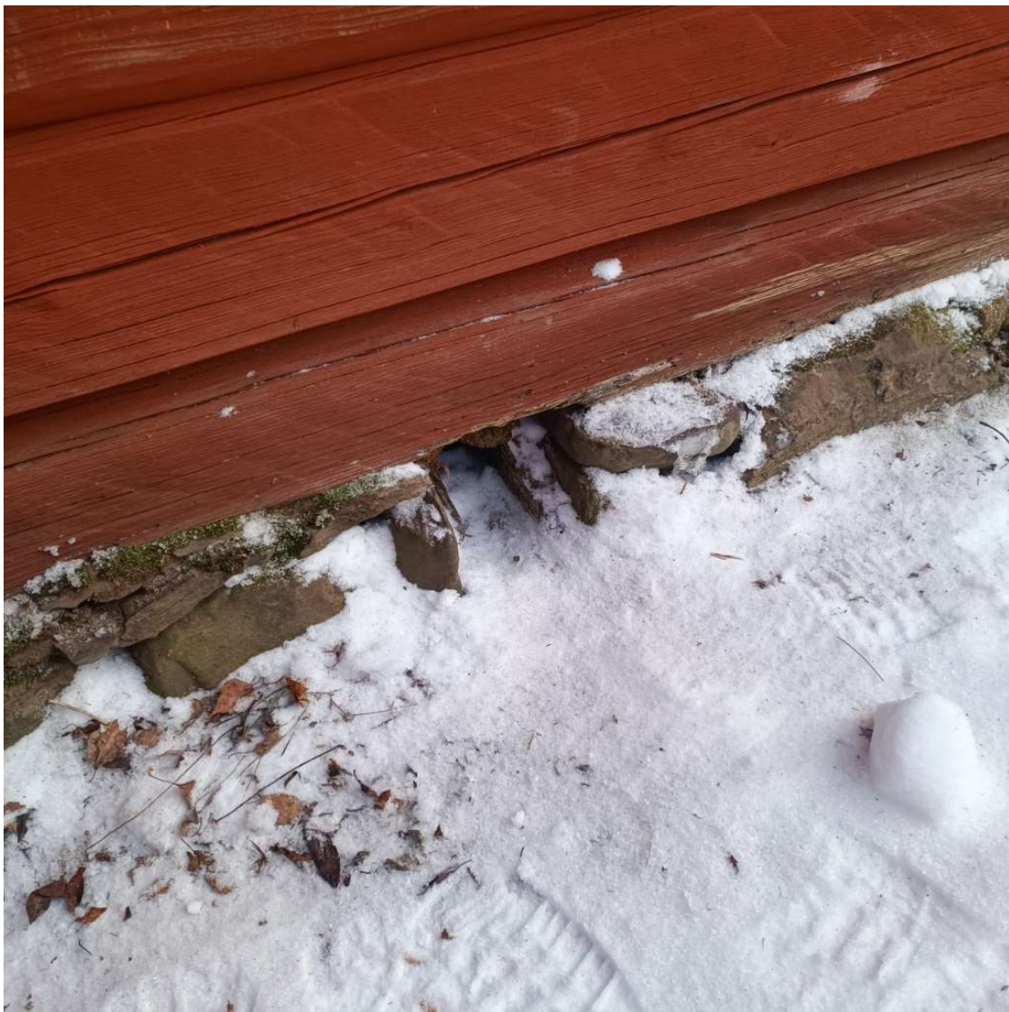
Kuva 13. Tuuletusluukku (Kuva: M.R).
