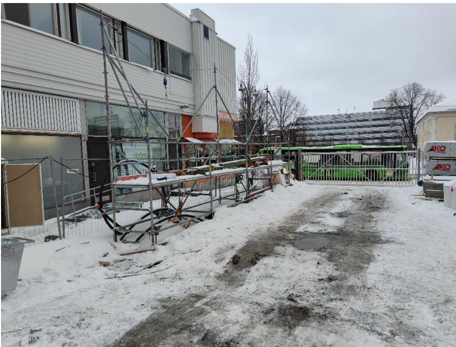
Kuvio 6. Työmaan ajoportti 1 ja ontelopurkuteline
