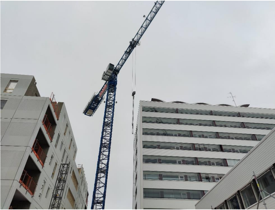
Kuvio 9. Torninosturi työmaalla
