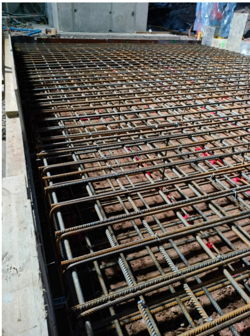
KUVA 2. Laatan raudoitusta (Kuva: Otto Louko).
