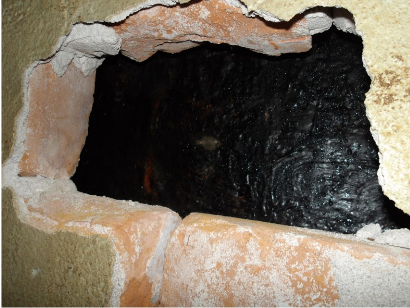
Kuva 6. Kuorimuuraus, jonka takana bitumisively.
