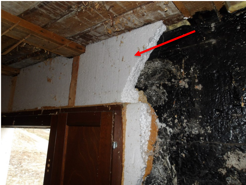
Kuva 4. Sisäpuolelle tehty lämmöneriste.
