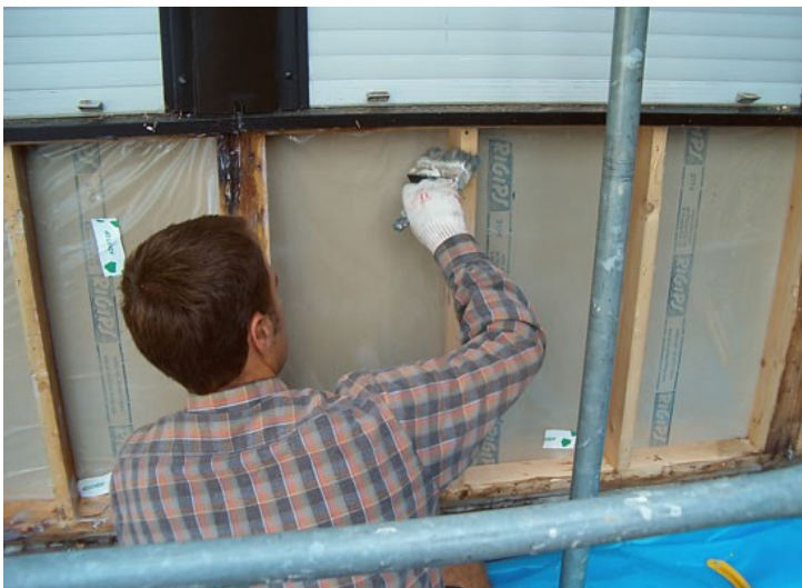
Figur 15: Bestrykning av renopan ToxStop på behandlad träyta (Zimmerer-Profibau Fertighaussanierung, u.å.b).
