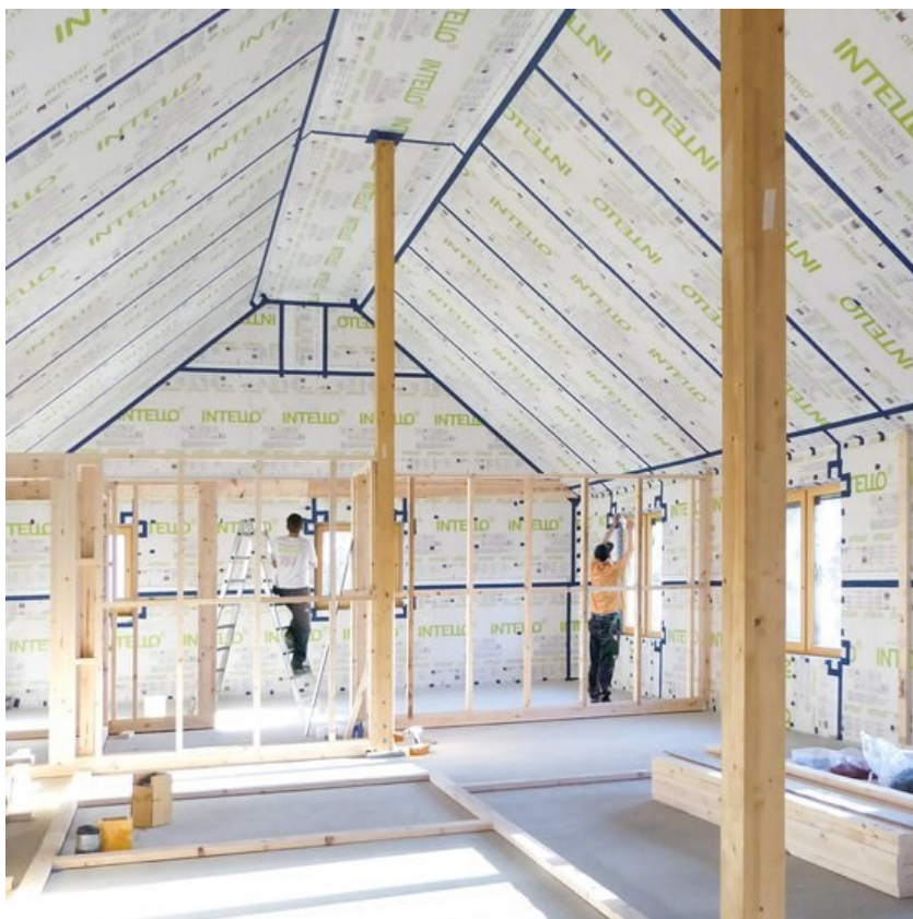
Figur 10: Montering av Intello i väggar och tak. Fogar tätas med tillhörande tejp. (Pro Clima, u.å.).
