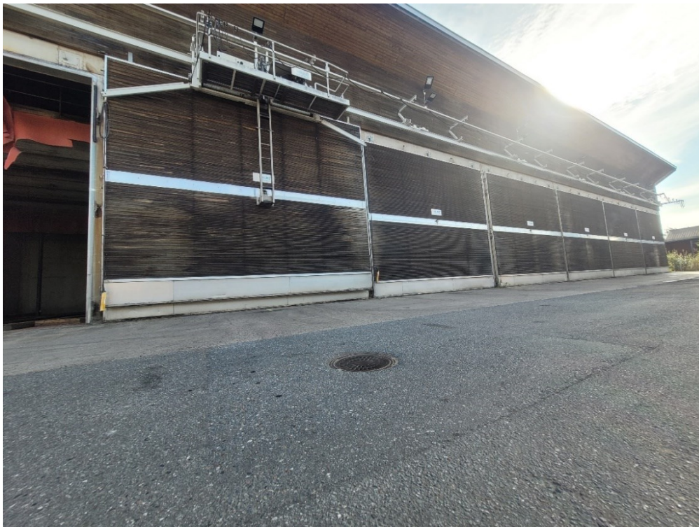
Kuva 1. Valokuva ovensiirtolaitteen ympäristöstä.
