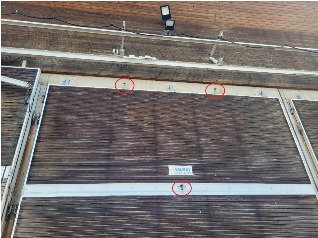
Kuva 5. Valokuva oven nostokohdista.
