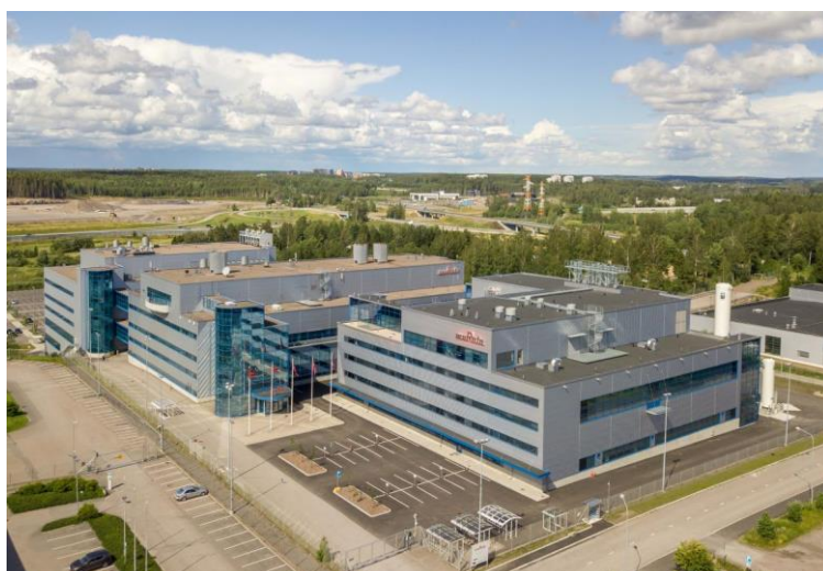
Kuva 1. Murata Electronics Oy Vantaan toimipiste [2].
