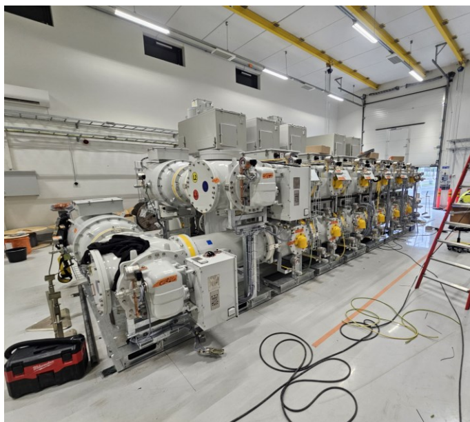
Figur 3. Ett GIS ställverk under konstruktion.
