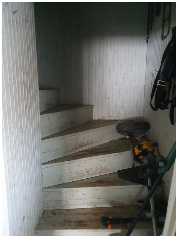
Ullakolle johtavat portaat ovat kuluneet
