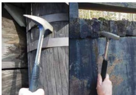
KUVA 4. Silta rakenteiden koputtelua lahon paikantamiseksi (White & Ross 2014, 5).
