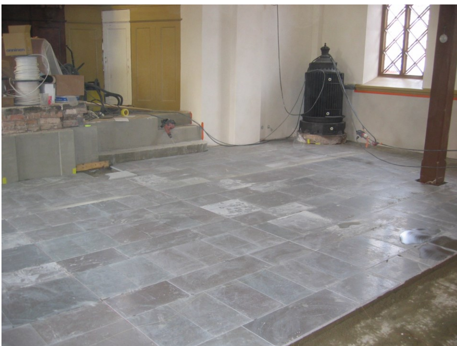
Kuva 44. Kirkon uuden lattian asennus. (Kuva: Kalevi Näkki 2008)
