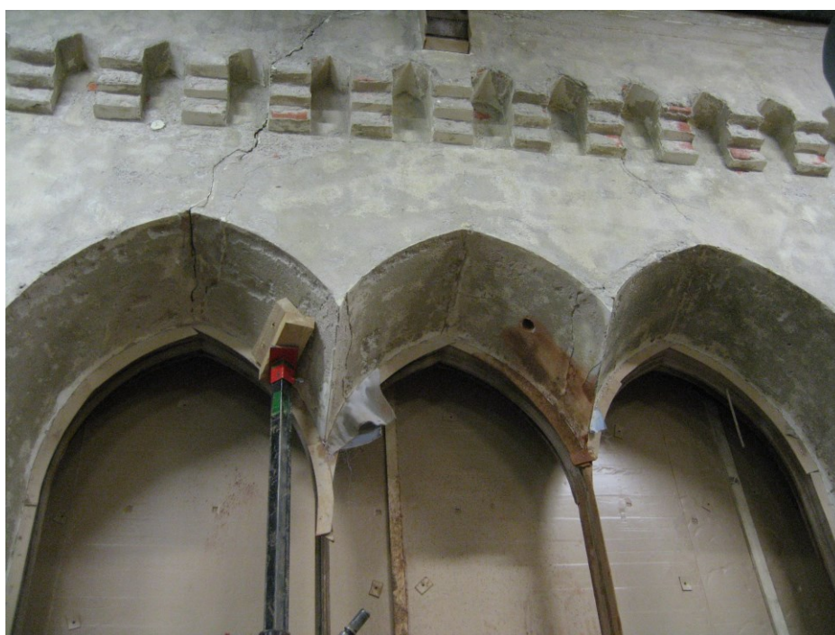
Kuva 45. Haljennut pitkän julkisivun ikkuna, vanhat rappaukset irrotettu. (Kuva: Kalevi Näkki 2008)
