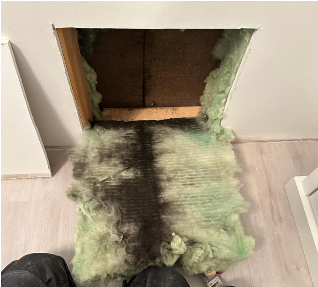
Kuva 15. Rakenteenavaus valesokkeli tutkimuksessa.
