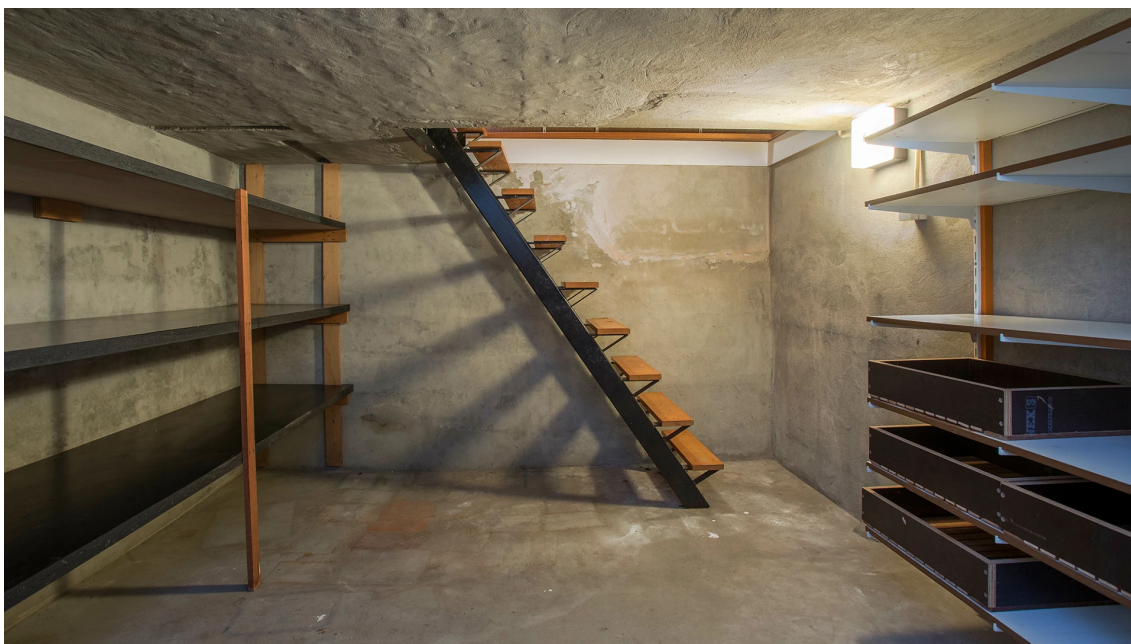
Kuva 11. Kellari, jossa yläpuolella betonilaatta. [27.]
