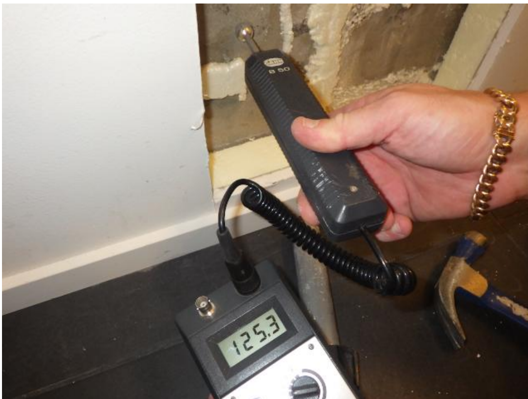
Kuva 18. Pintakosteuksien mittausta maanvastaisesta seinärakenteesta.
