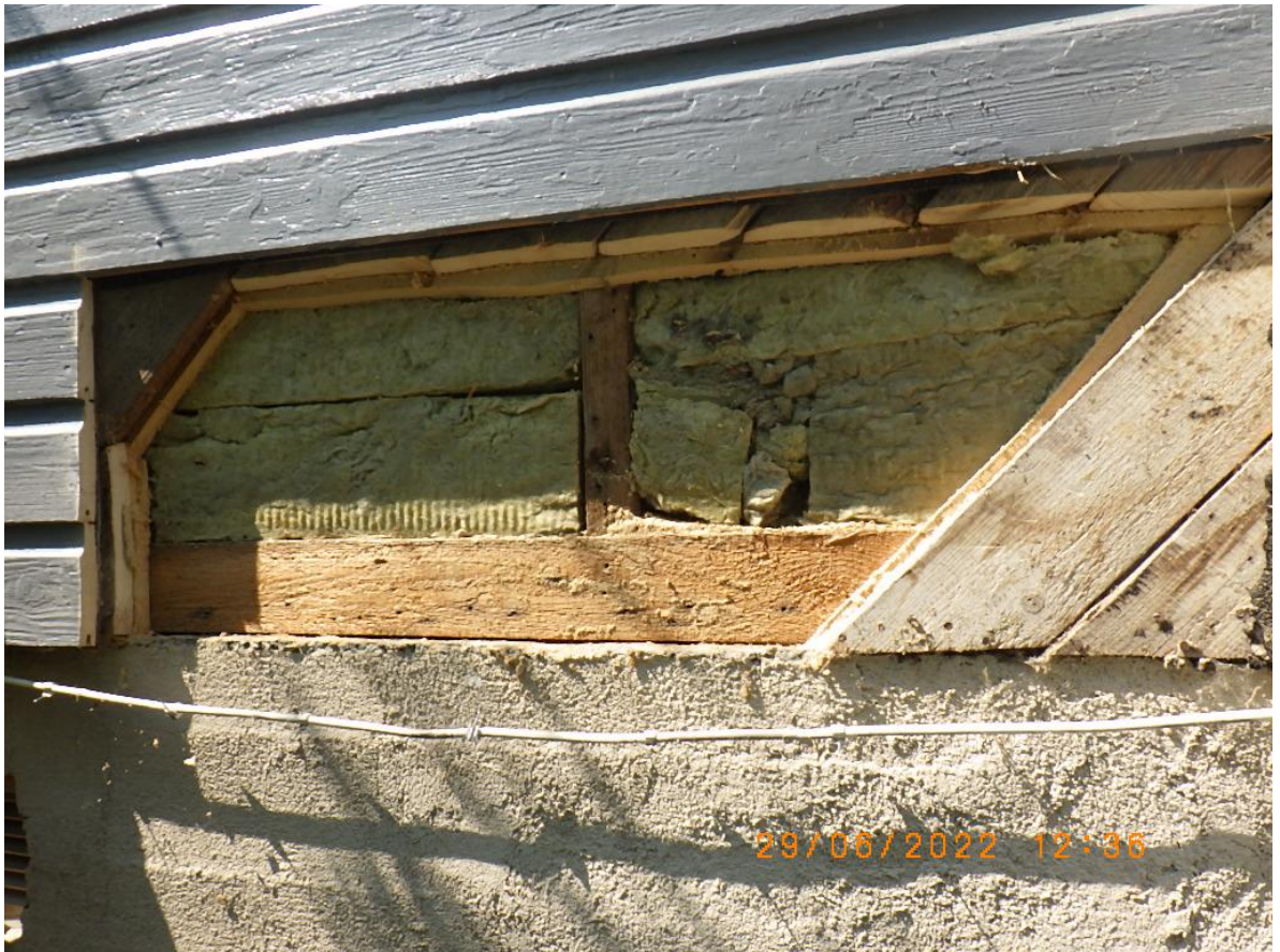
Kuva 12. Betonilaatan päälle puukoolattua lattiarakennetta on tutkittu julkisivuverhouksen kautta.
