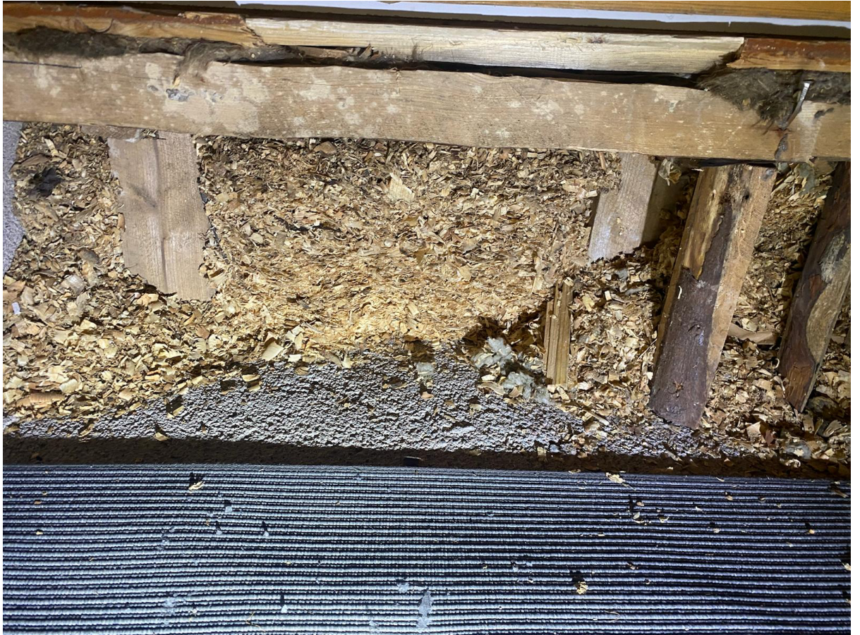
Kuva 1. Betonilaatan päälle puukoolattu lattiarakenne purueristeellä.
