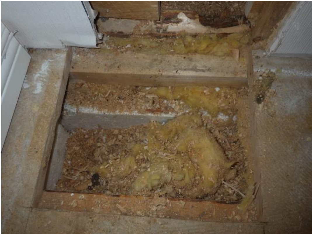
Kuva 21. Rakenteenavaus betonilaatan päälle puukoolatusta lattiarakenteesta. Lämmöneristeenä on kutterinlastua, sahanpurua ja mineraalivillaa.
