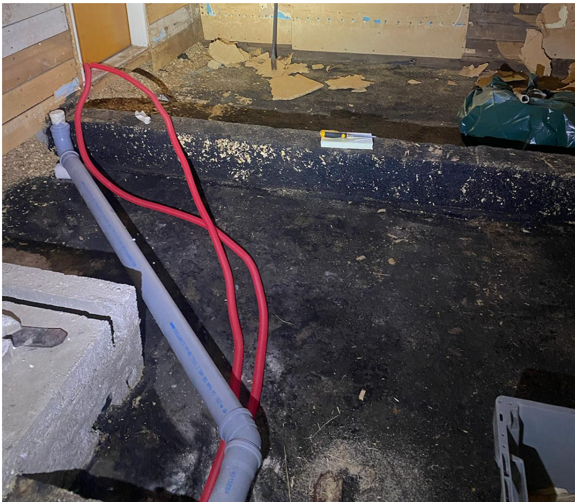
Kuva 4. Lattian rakenteisiin on laitettu bitumisively.
