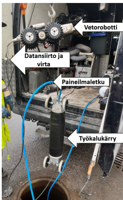
Kuva 4. Yhdistelmärobotin alas lasku viemäriputkeen
