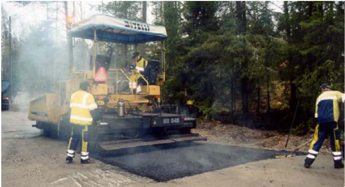
Kuva 16, Tiehallinto – päällysteiden korjaus. AB-paikkaus konetyömenetelmällä.
