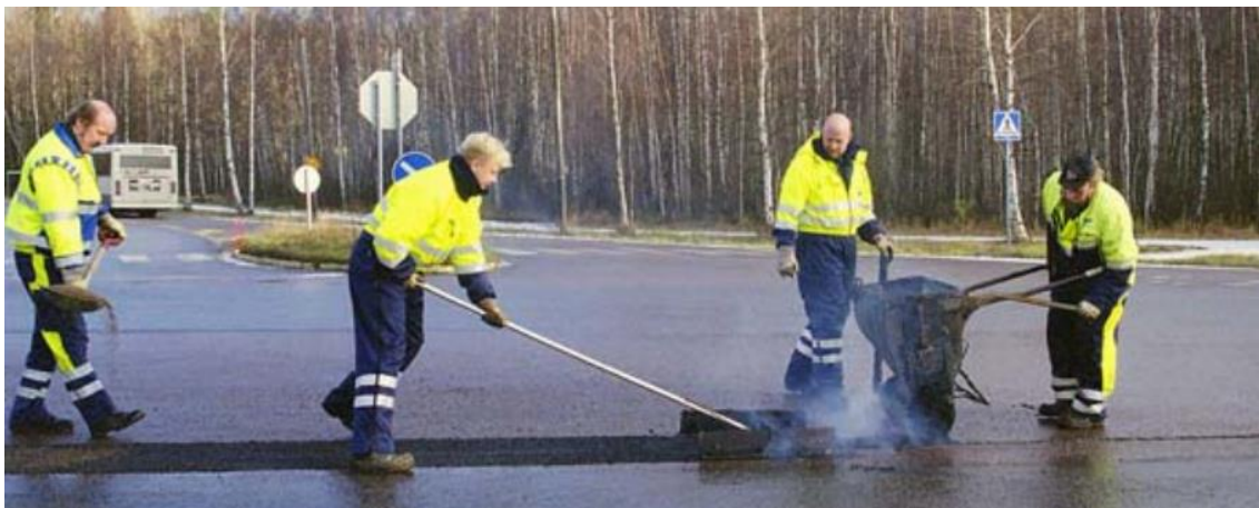
Kuva 18, Tiehallinto – Päällysteiden korjaus. Valuasfalttipaikkaus käsityönä.
