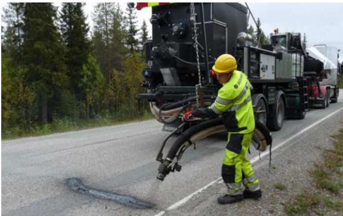
Kuva 21, Tiehallinto – Päällysteiden korjaus. Sirotepuhalluspaikkausta.
