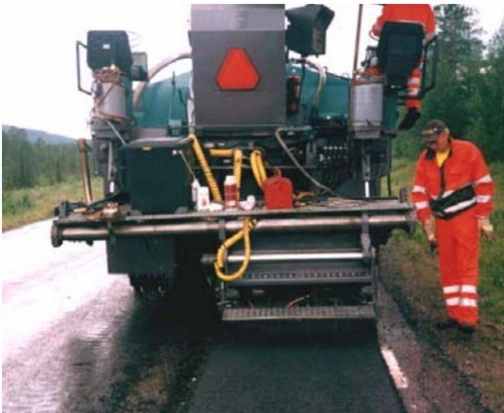
Kuva 23, Tiehallinto – Päälysteiden korjaus. Uraremo-paikkaus.
