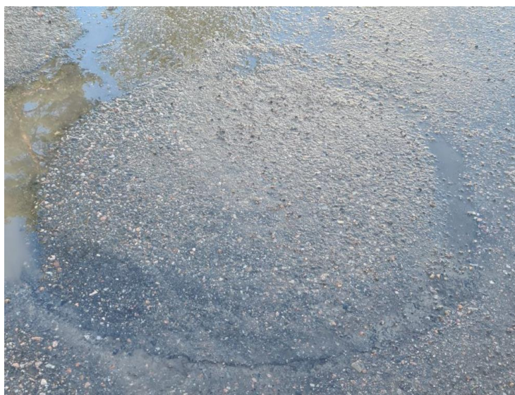
Kuva 17. Käsityömenetelmällä tehty pysyvä PAB-paikka.
