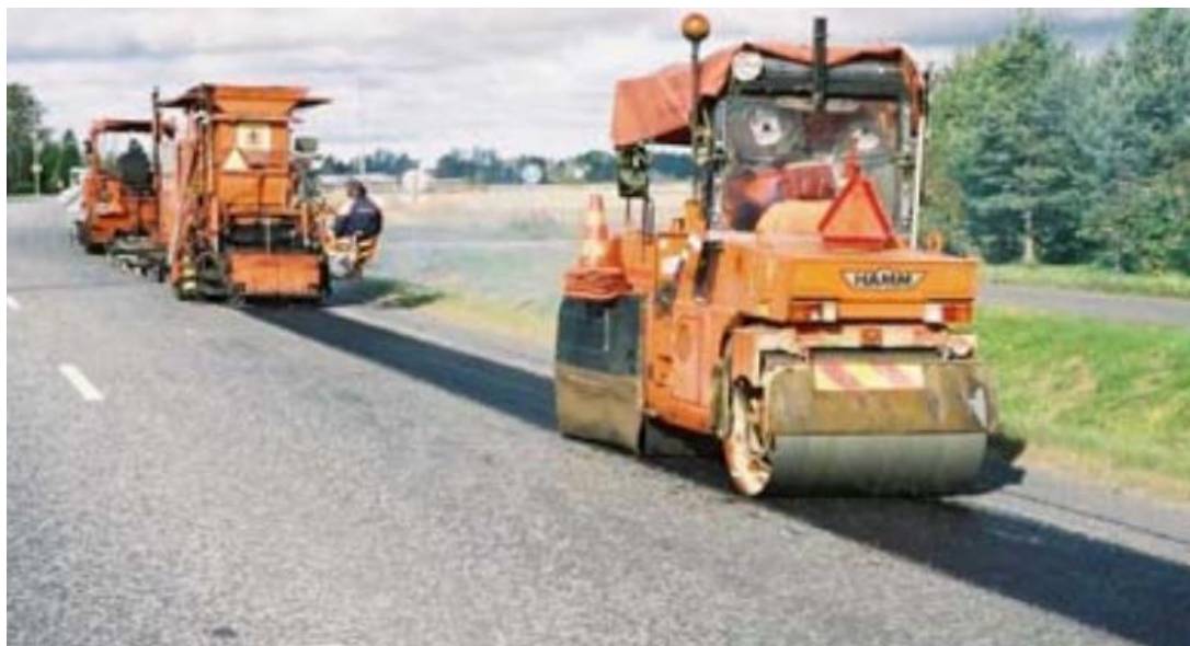
Kuva 22, Tiehallinto – Päälysteiden korjaus. Uraremix-paikkaus.
