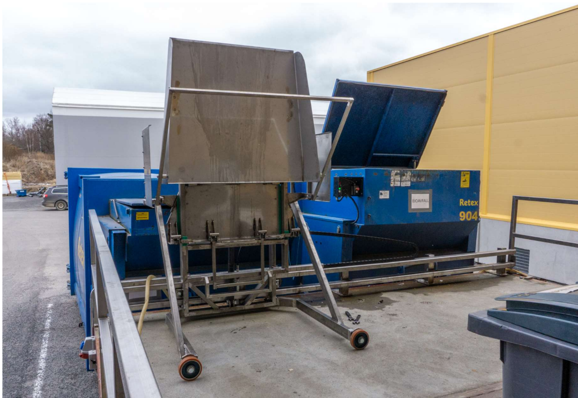
Figur 23 - Den färdiga produkten installerad hos beställaren.
