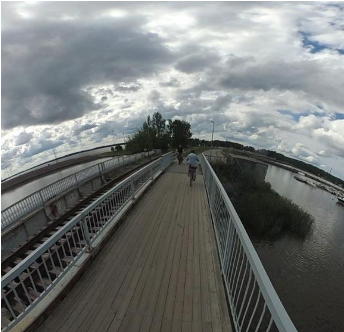
Kuva 7. Vaskiluodon jalankulun ja pyöräilyn silta. Kuvakaappaus videolta (Petri Papunen)
