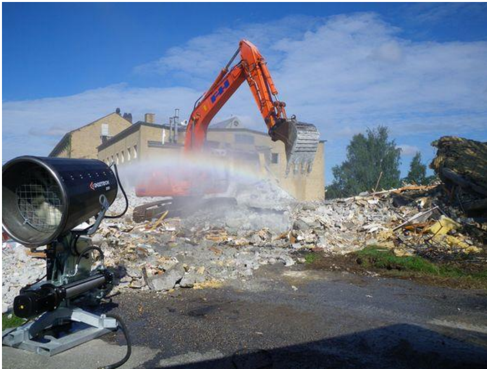
Kuva 5. Duztec-vesitykki purkukohteessa (Hansa-Machines 2024).
