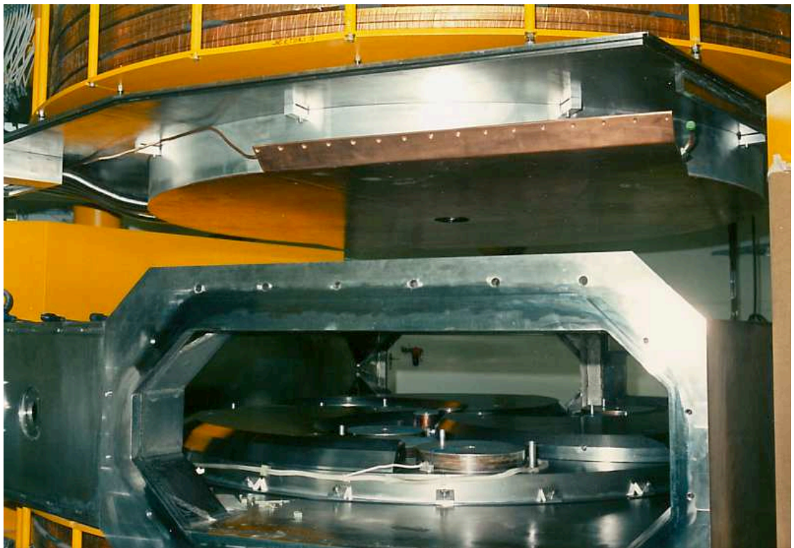
Kuvio 11. Historiakuvaa K-130 syklotronin tyhjiökammion kokoamisesta. Yläpuolella Liner-vuoraus on paikallaan ja alapuolella vuoraus vielä puuttuu (Taskinen 1990)
