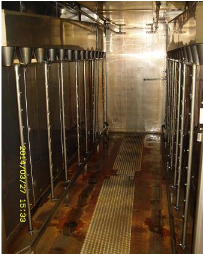
Kuva 8. Restia 4 -uuni. Vesihöyry johdetaan uuneihin molemmilla puolilla näkyvistä suppiloista. Vaunut sijoitetaan uuneihin perätysten jokaisessa uunissa, kuten tästä kuvasta näkyy. (Kuva: Martti Raski)
