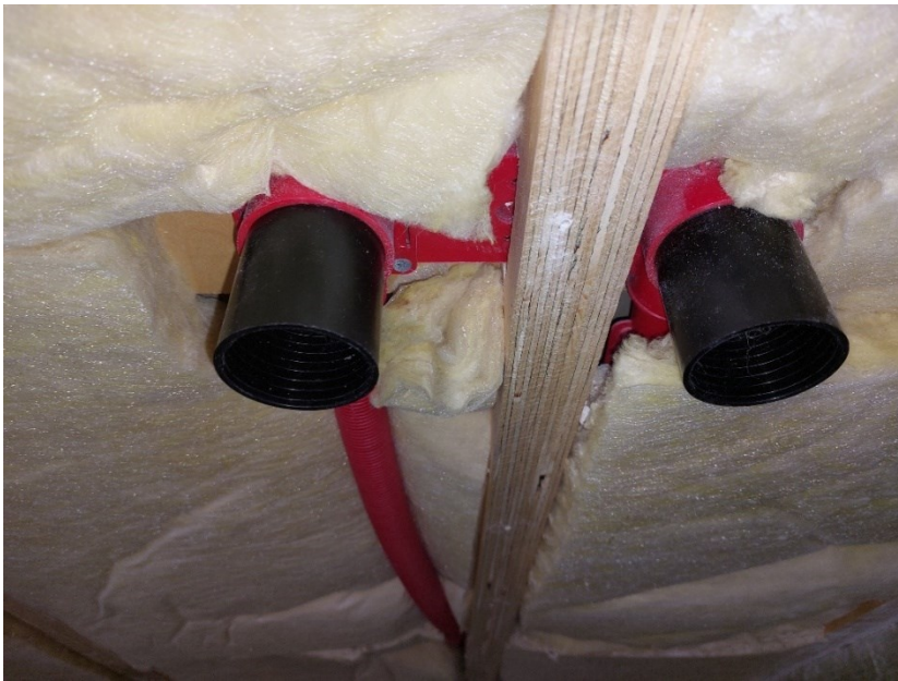
Kuva 4. Hanakulmarasioihin asennetut jatkoholkit.
