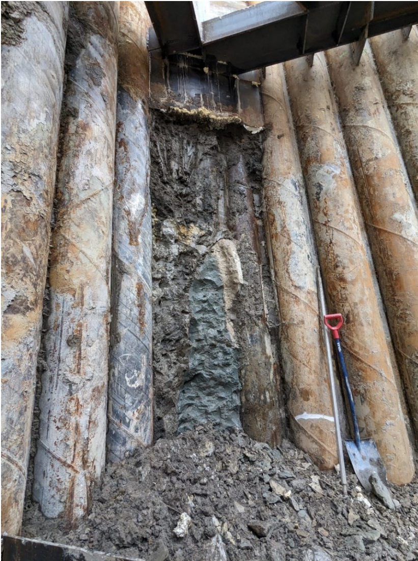
Kuva 14. Suihkuinjektointipilari porapaaluseinän epäjatkuvuuskohdassa
