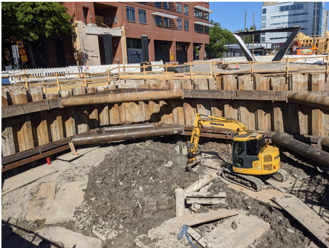
Kuva 10. Teräsponteilla toteutettu kaivanto
