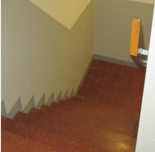
Kuva 15. Käsijohde puuttuu
