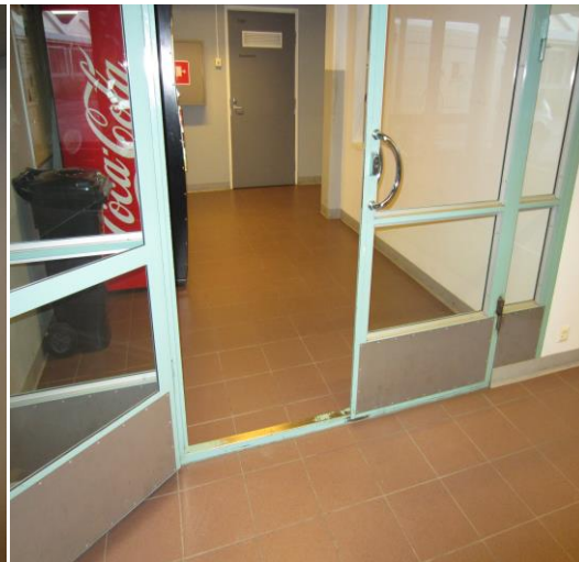
Kuva 19. Hissiin johtavan käytävän kynnyks.
