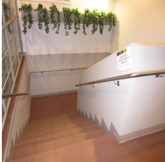
Kuva 16. Pohjakerrokseen johtava rappu
