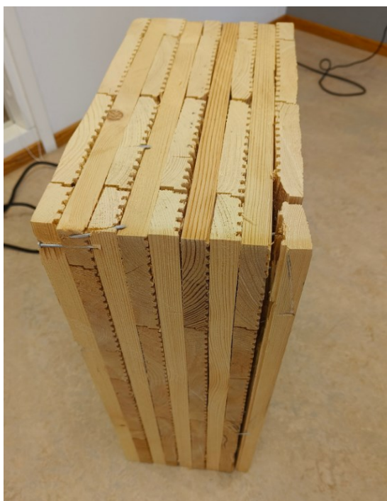
Figur 1. Korsvis staplad MHM-element som är ihop fäst med räfflade aluminiums spikar. (Alén,2024).
