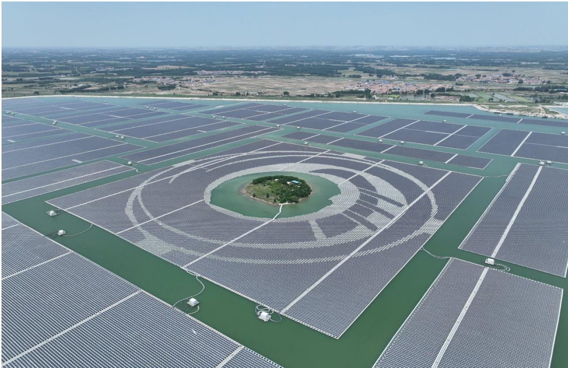
Figur 21. En del av anläggningen i Dezhou.
