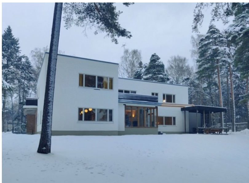
Kuva 20. Kantola ulkoa kuvattuna. (Sunilan Kantola Oy s.a.)
