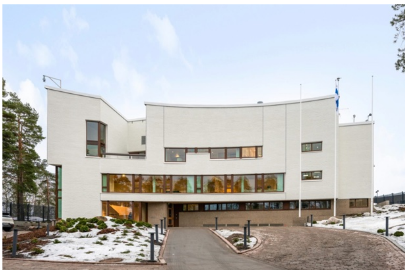
Kuva 9. Valtion Vierastalon julkisivu. (Senaatti s.a.)
