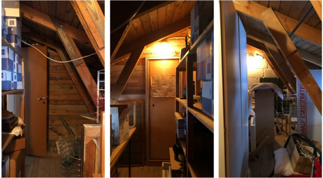
Kuvakollaasi 2. Makuuhuoneiden ja ulkoseinän välisiä vinttitiloja
