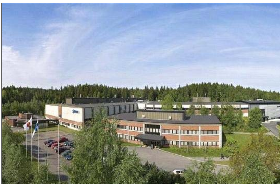
Kuva 1. Santen Oy, Tampere /34/
