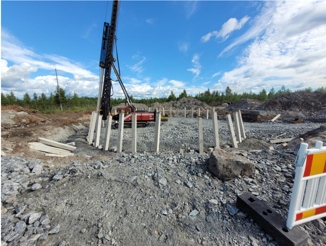
KUVA 7. Tuulivoimalan perustuksen paalutus. (Kuva: Lehtinen, Mika Ramboll CM)
