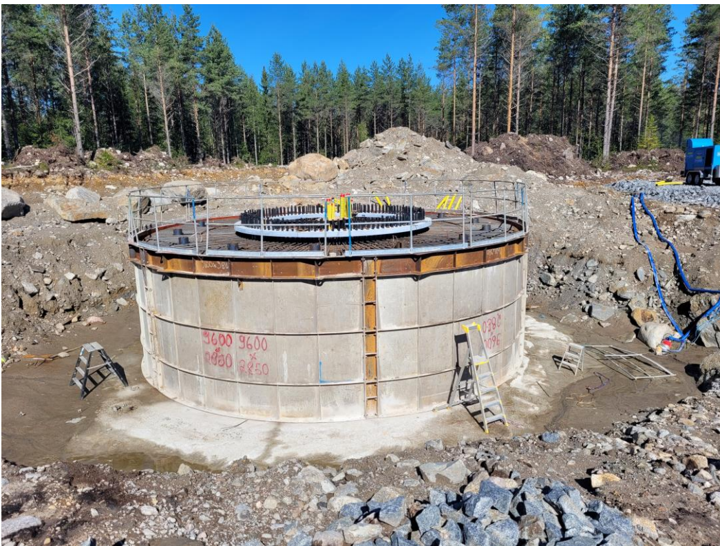
KUVA 6. Tuulivoimalan kallioankkuroitu perustus. (Kuva: Lehtinen, Mika Ramboll CM)
