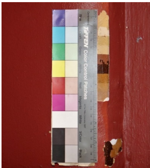
Kuva 34. Lipunmyyntipisteen seinän esiinotto (2024)
