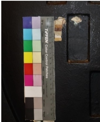
Kuva 61. Pilasterin alaosan esiinotto (2024)
