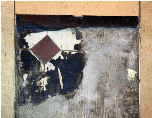
Kuva 49. Lämpöön muovimaton alta pilkistävä laatoitus (2024)
