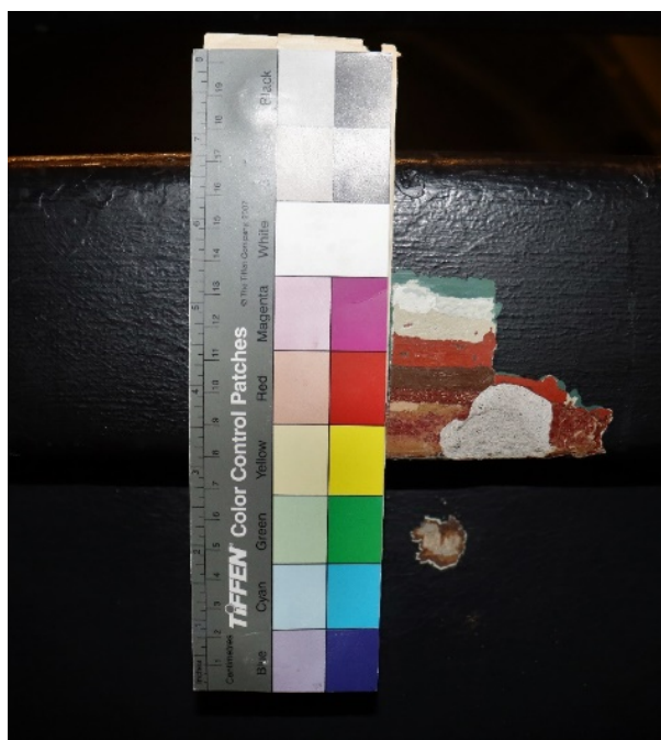
Kuva 63. Teatterisalin parven kaiteen esiinotto (2024)
