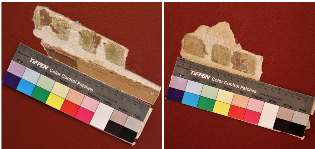
Kuva 45. Porraskäytävän 1. esiinotto (2024) Kuva 46. Porraskäytävän 2. esiinotto (2024)
