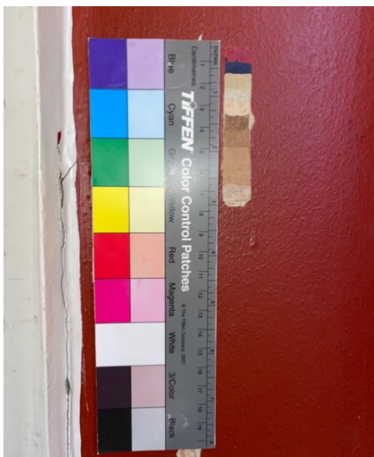
Kuva 50. Lämpiön seinän esiinotto (2024)
