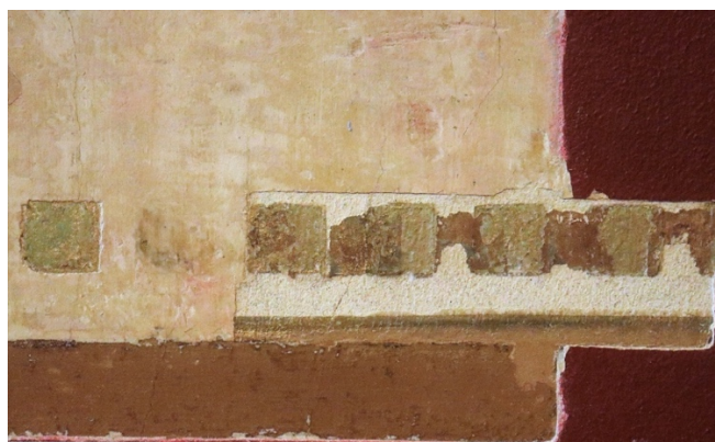
Kuva 44. Lähikuva porraskäytävän laajennetusta esiinotosta (2024)
