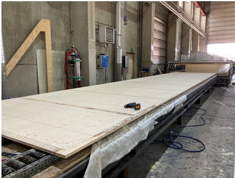
Kuva 27. Koneistettu pohjalevy odottamassa ripojen rakenneliimausta
