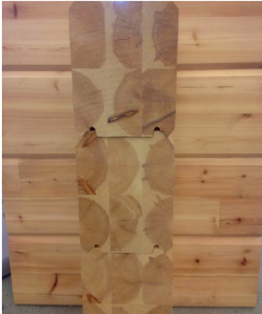
KUVA 3. Lamellihirsi, jossa sydänpuu asetettu ulospäin (kuva M.Venäläinen)
