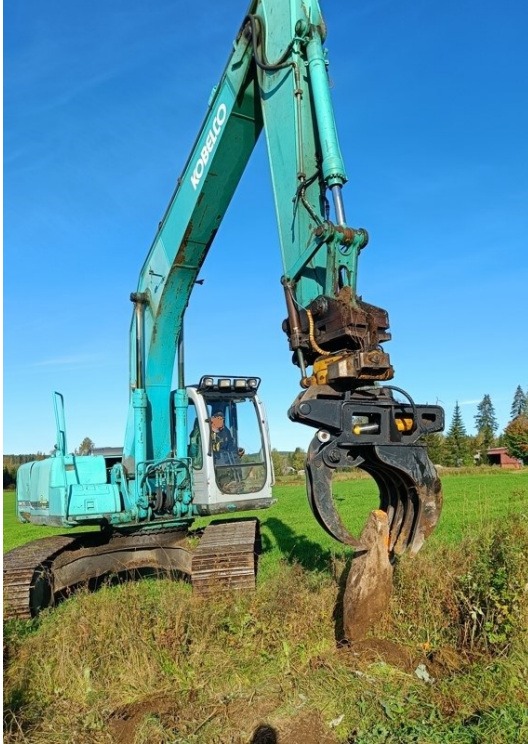
Kuvio 9. Siirtynyt kivipyykki korjataan oikealle paikalleen kaivinkoneen avustuksella.
