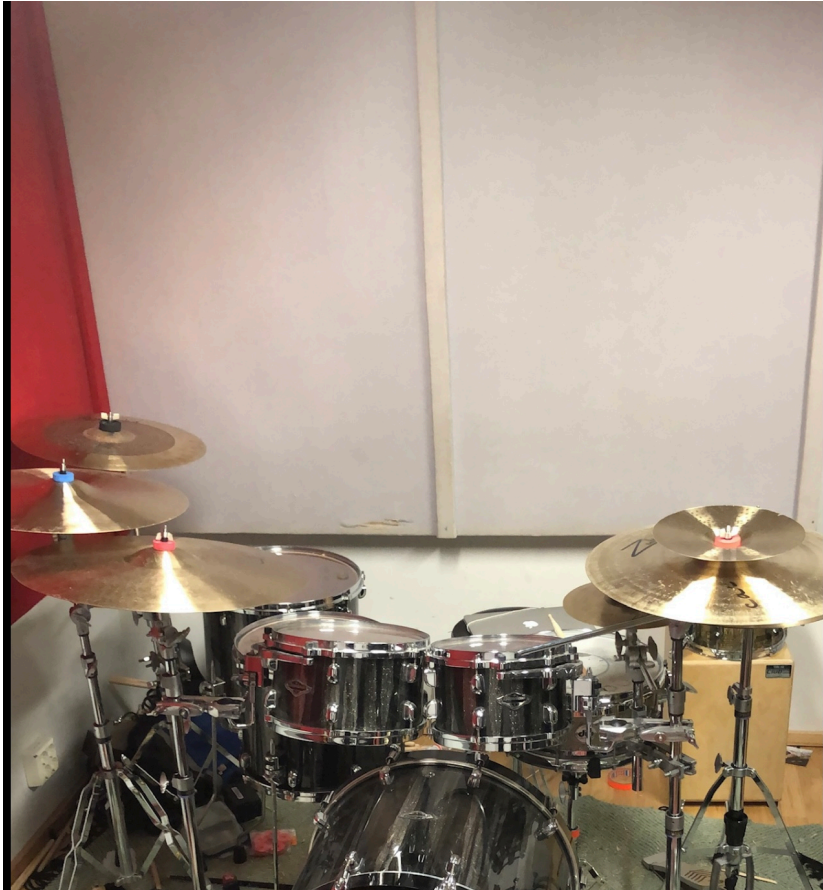
Kuva 1. Akustiikkapaneelit seinälle ripustettuina.
