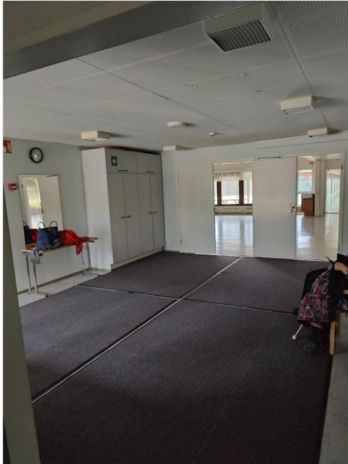
Kuva: Aulan yleiskuva
