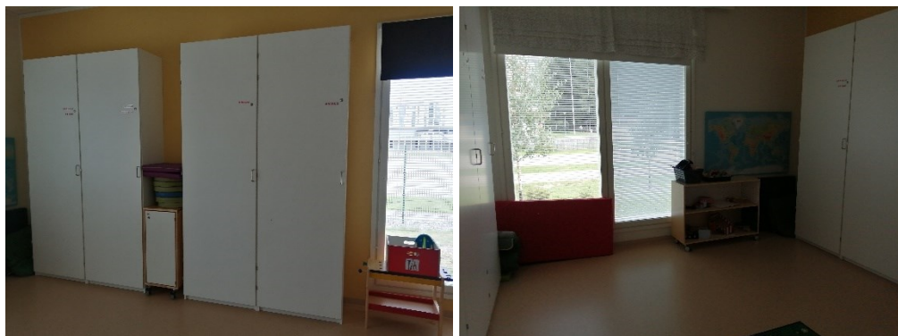
KUVA 13a ja 13b. Päivälepuhuone ennen muutosta (Soukka 2023, CC BY-NC)
