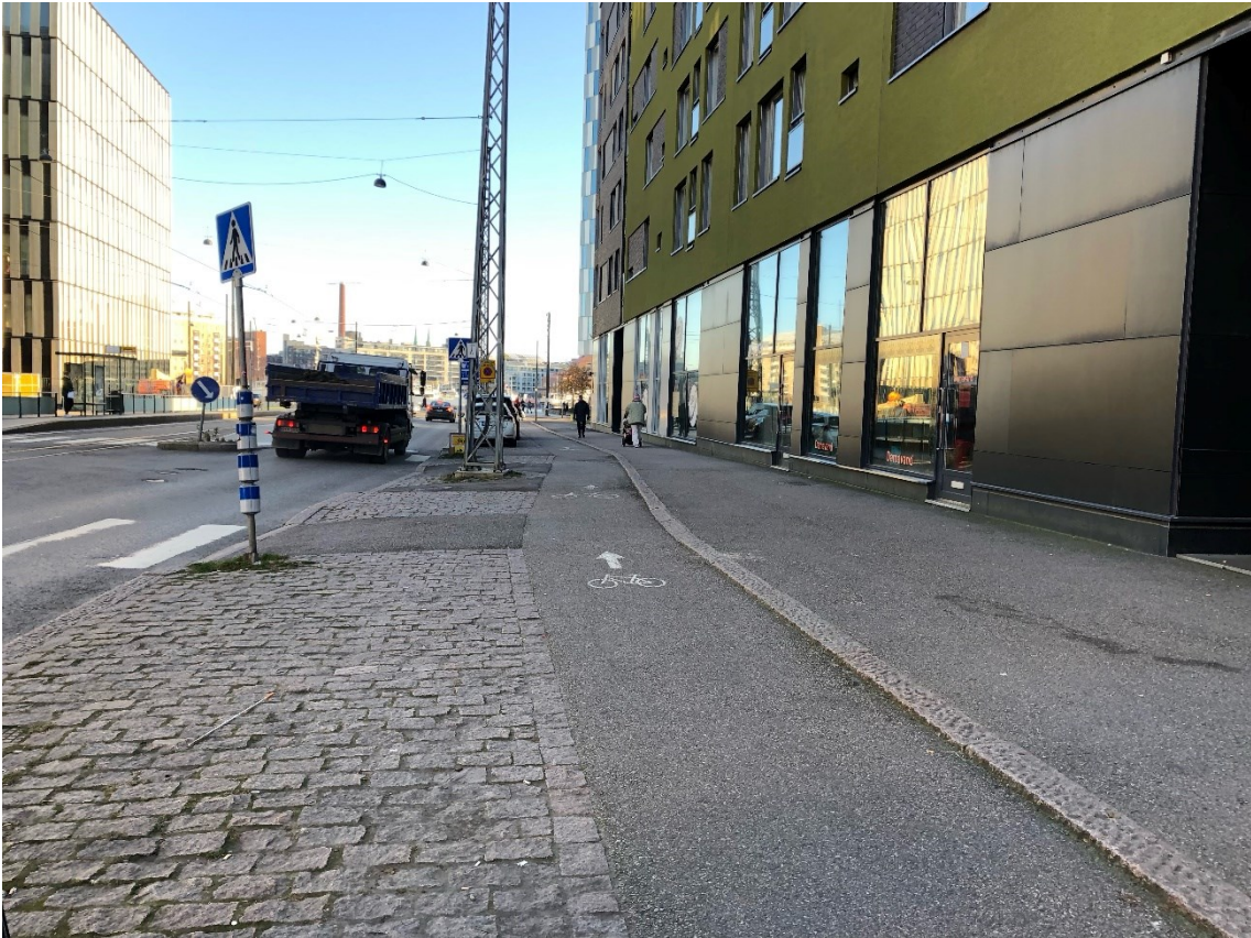
Kuva 36. Välimerenkadun nykyisiä suunnitteluohjeita kapeampi tasoeroteltu 1-suuntainen pyörätie, ennen ensilumia.
