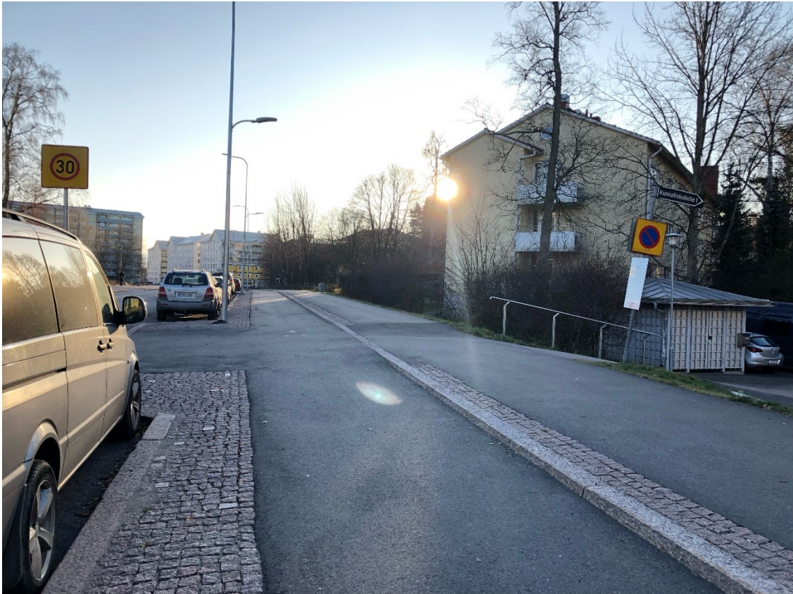
Kuva 19. Kunnalliskodintien tasoeroteltu 1-suuntainen pyörätie ovenavaustilalla sekä erotuskaistalla kohti Koskelantietä ennen ensilumia.
