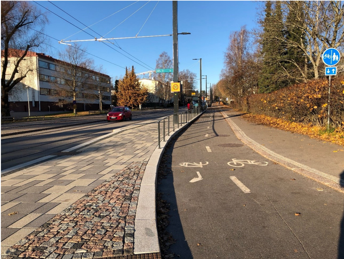
Kuva 23. Norrtäljentien tasoeroteltu 2-suuntainen pyörätie Raide-Jokeri pysäkin kohdalta pohjoisen suuntaan ennen ensilumia.
