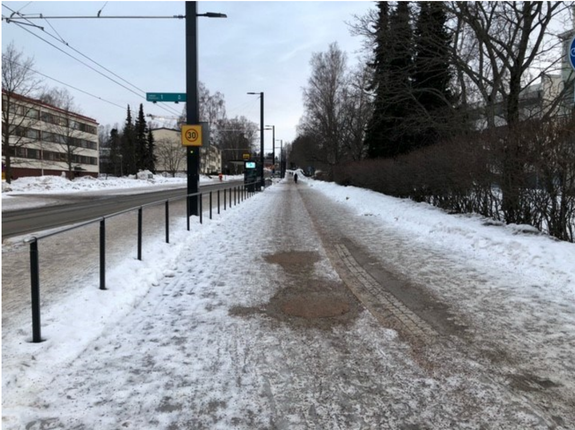
Kuva 26. Norrtäljentien luminen tasoeroteltu 2-suuntainen pyörätie Raide-Jokeri pysäkin kohdalta pohjoisen suuntaan, jossa tasoero sekä reunakivi on hävinnyt lähes täysin.
