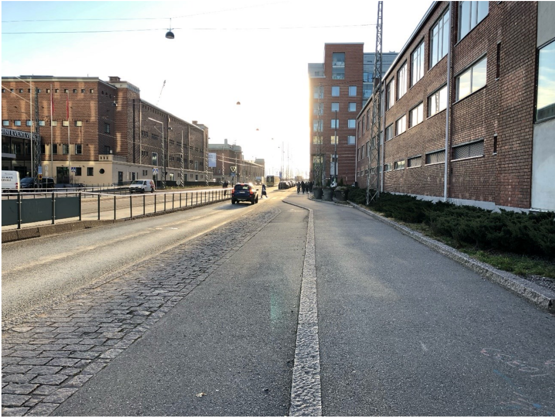
Kuva 32. Tyynenmerenkadun nykyisiä suunnitteluohjeita kapeampi tasoeroteltu 1-suuntainen pyörätie kohti etelää ennen ensilumia.
