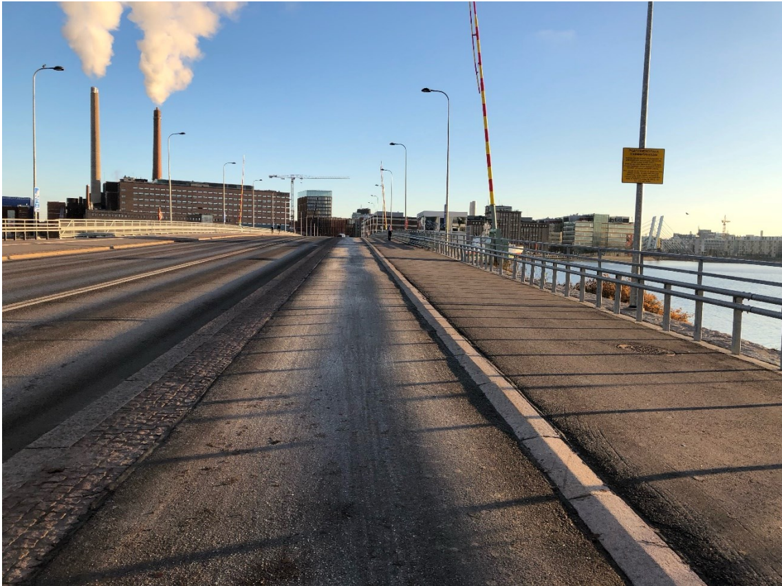
Kuva 30. Lauttasaarensillan tasoeroteltu 1-suuntainen pyörätie keskustan suuntaan ennen ensilumia.
