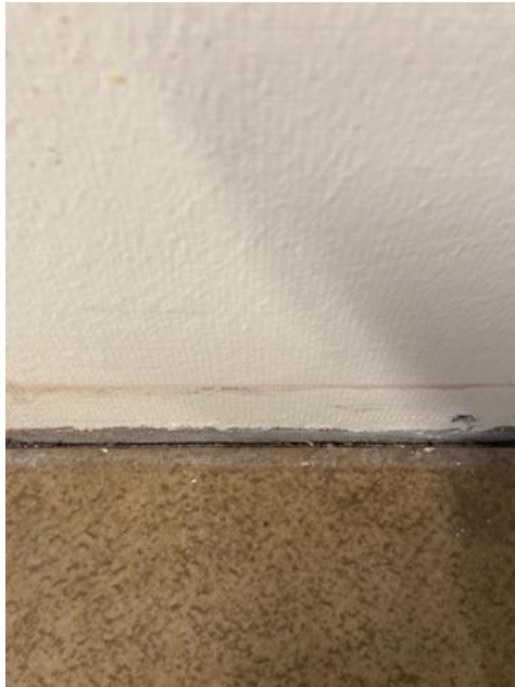
Kuva 14. Lista irrotettu ja liittymä puhdistettu. (Lahtinen 2024)
