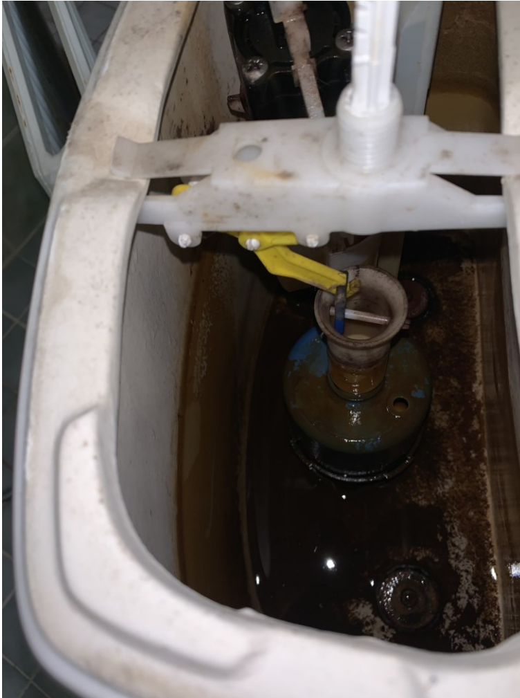
Kuva 5. Wc-istuimen säiliön sisäpuoli.
