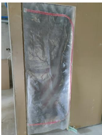
KUVA 8. Huoneiston eri tilojen osastointi vetoketjuovella (2024)
