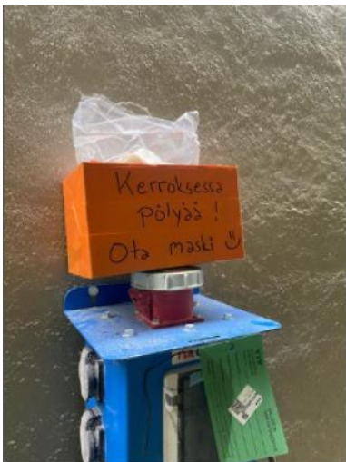
KUVA 32. Etuputsi ryhmän sijoittamat hengityssuojaimet ennen pölyävää kerrosta (YIT työmaat n.d.)
