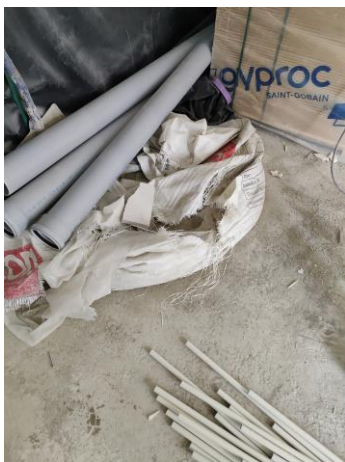
KUVA 16. Lähes tyhjä betonisäkki (2024)
